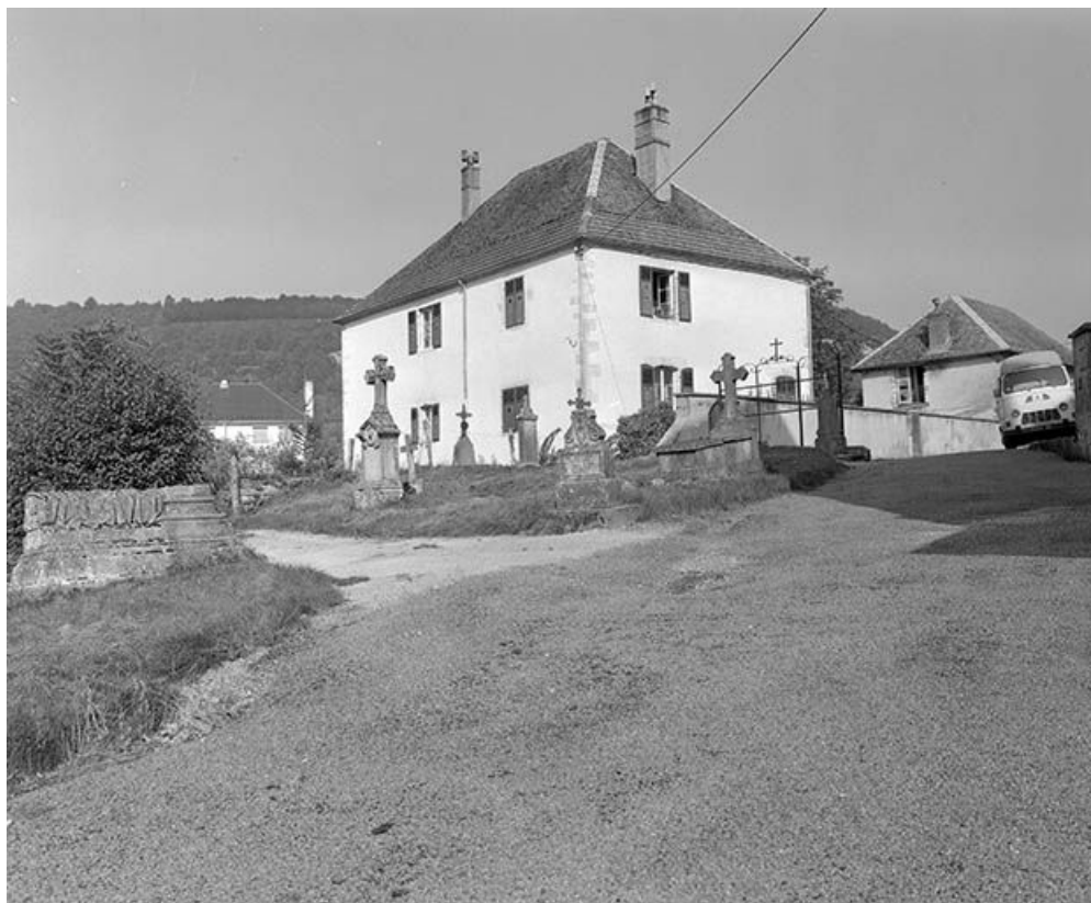
Façade postérieure et face latérale gauche.
