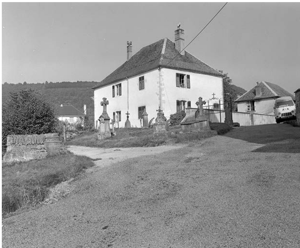
Façade postérieure et face latérale gauche.
