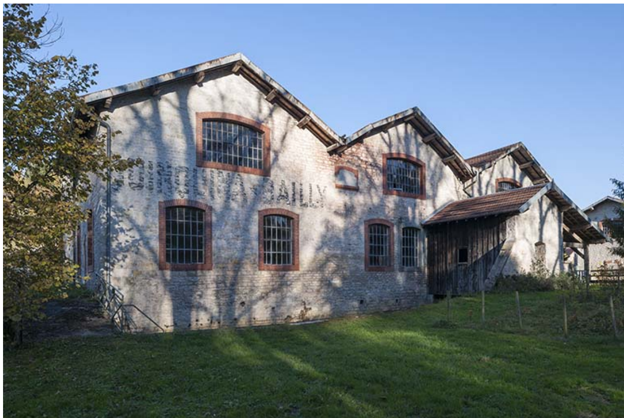
Ateliers ouest vus de trois quarts droite.
