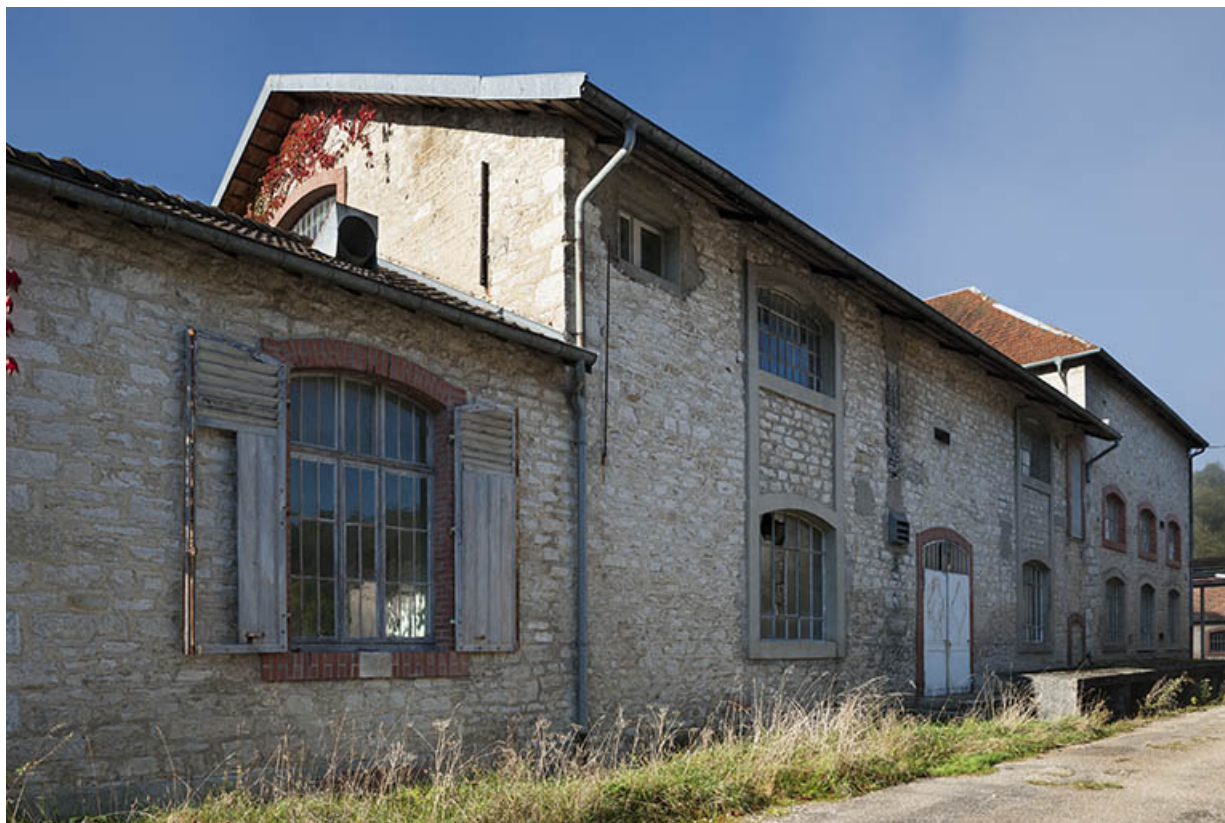
Façades est de l'atelier principal.
