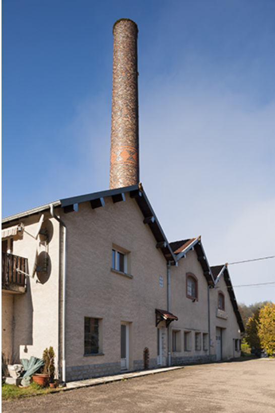
Vue de trois quarts gauche de la salle des machines. 25, Montgesoye rue du Moulin
