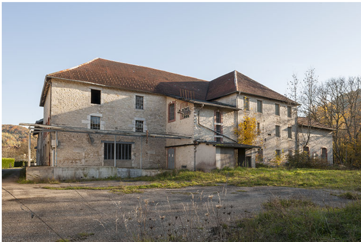
Atelier de fabrication vu depuis le nord.
