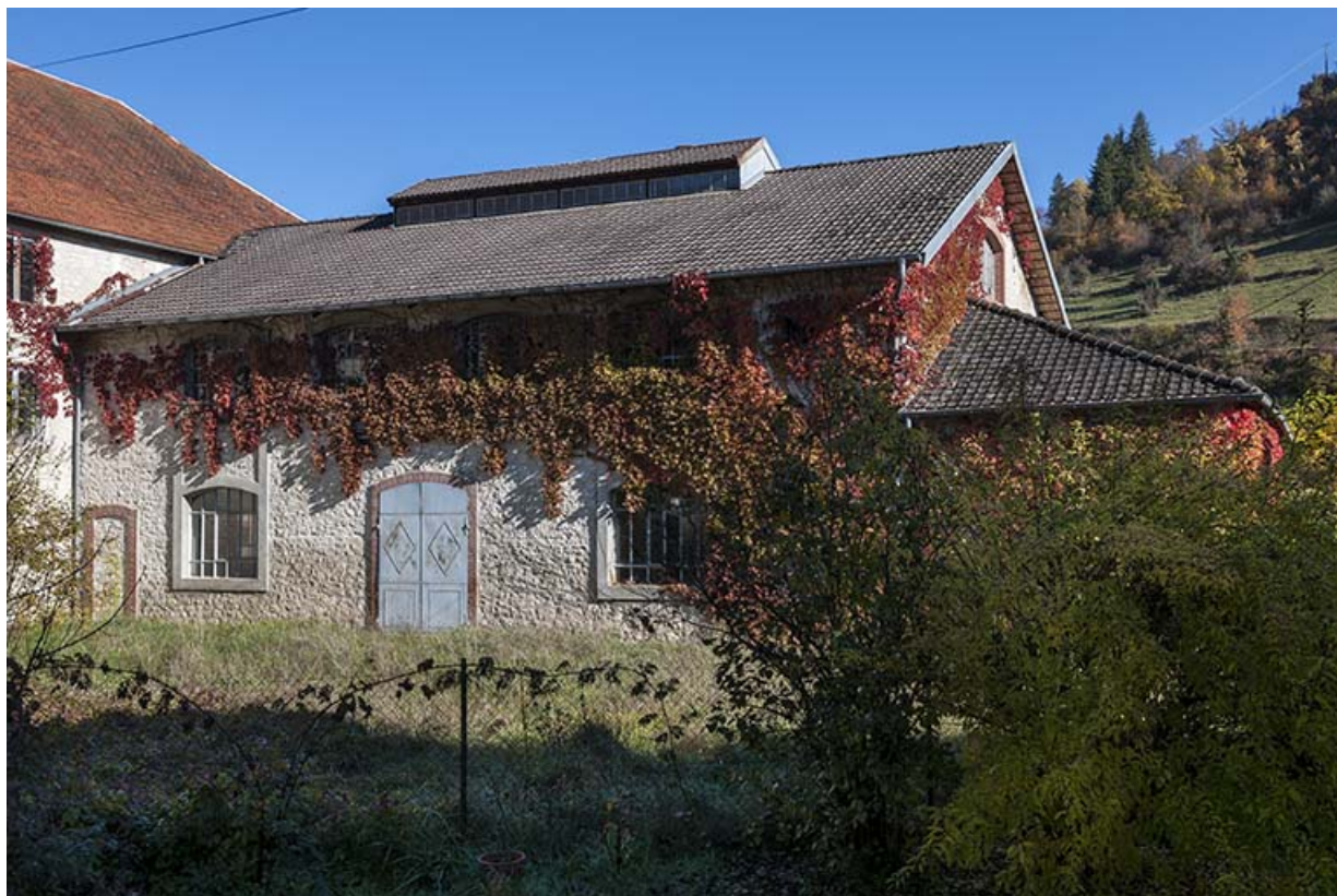
Bâtiment de la distillerie (salle des alambics ?). 25, Montgesoye rue du Moulin
