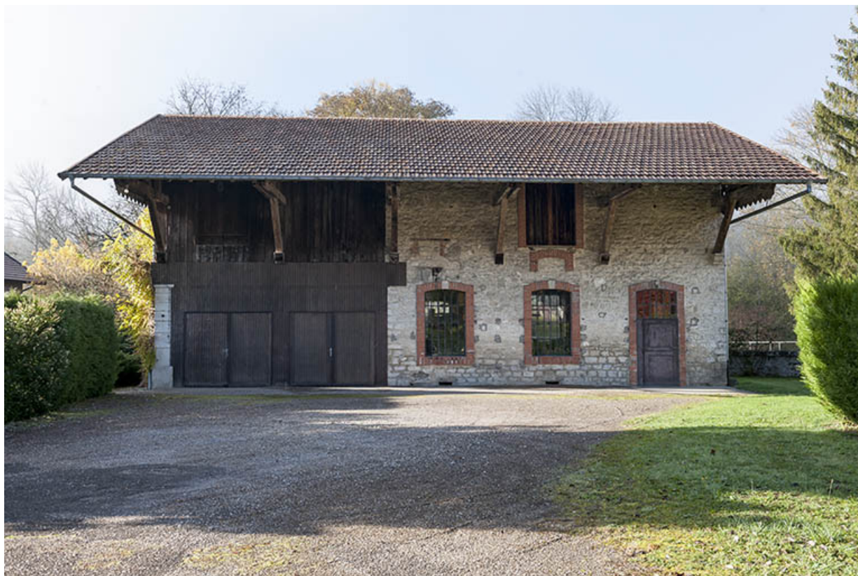
Entrepôt industriel. Face est. 25, Montgesoye rue du Moulin
