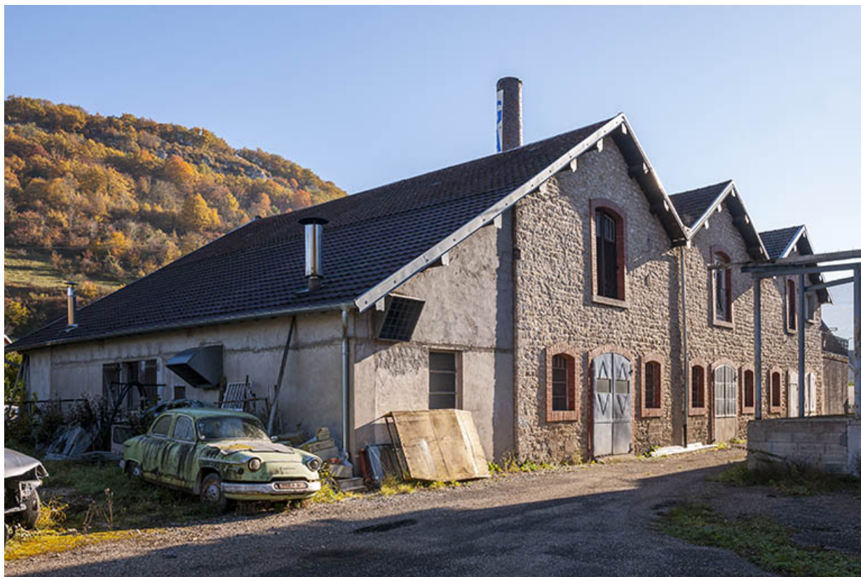
Vue de trois quarts arrière de la salle des machines.
