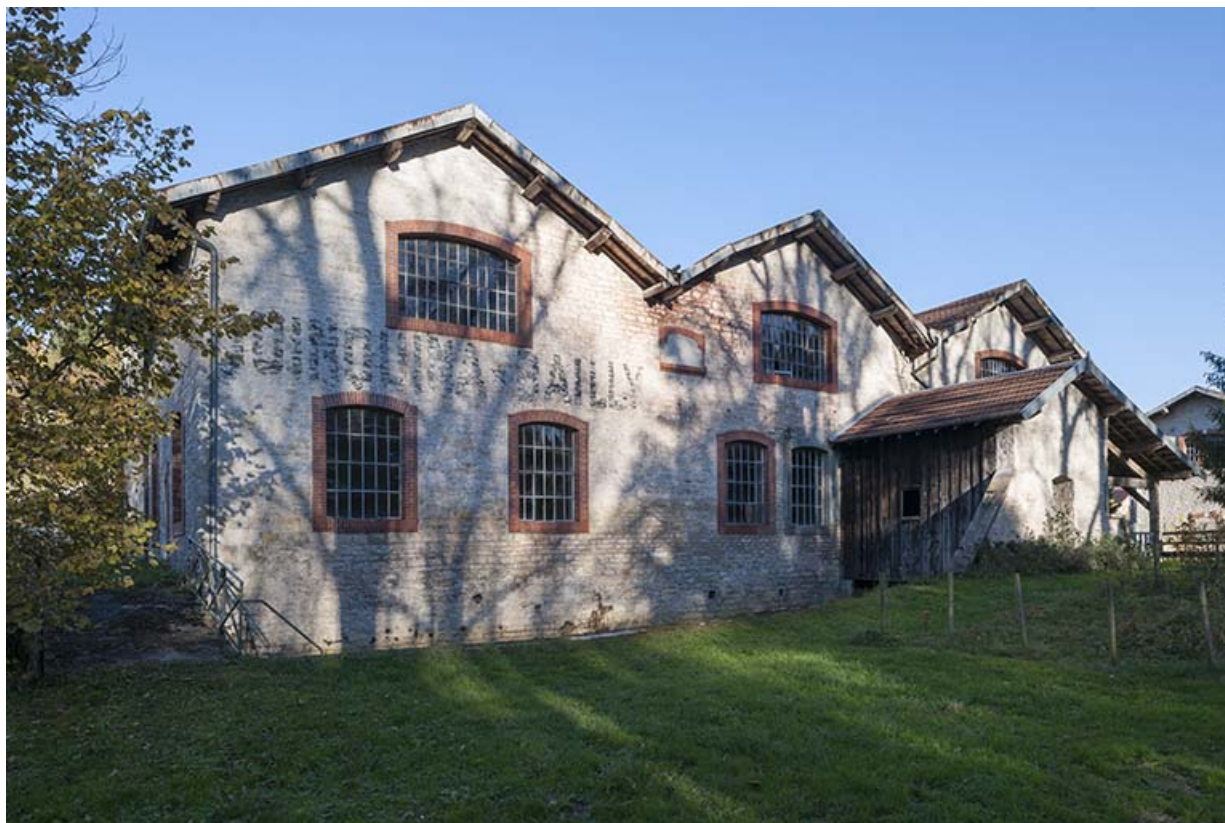
Ateliers ouest vus de trois quarts droite.
