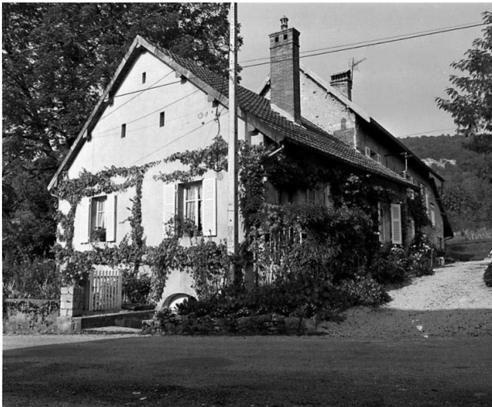
Façade antérieure et face latérale gauche. 25, Montgesoye
