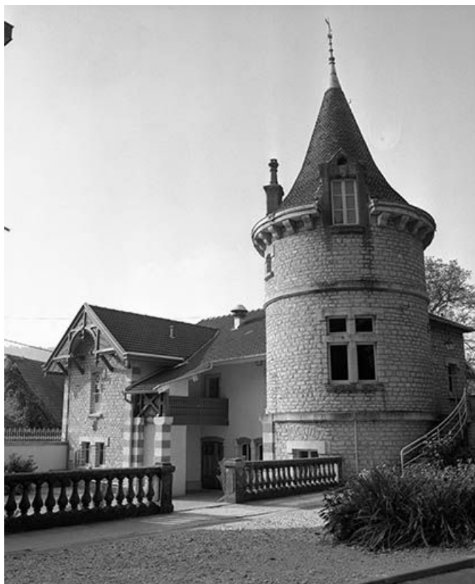
Façade antérieure des communs.
