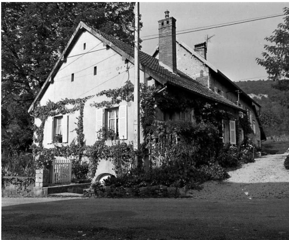
Façade antérieure et face latérale gauche. 25, Montgesoye
