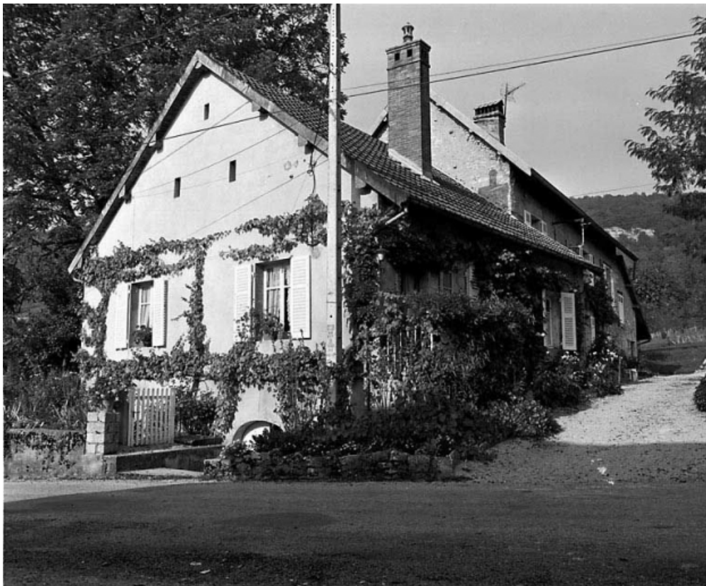
Façade antérieure et face latérale gauche. 25, Montgesoye
