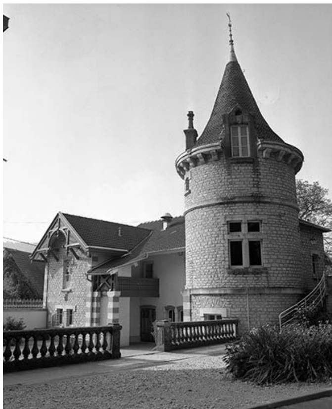
Façade antérieure des communs.
