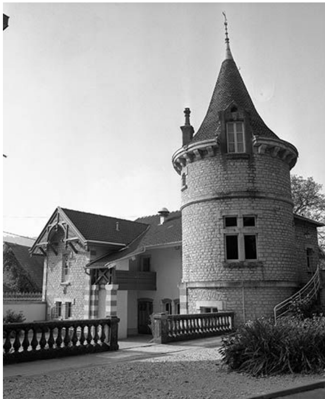
Façade antérieure des communs.
