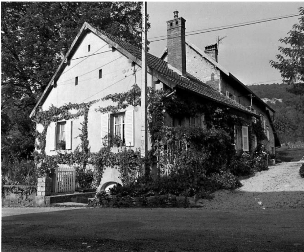
Façade antérieure et face latérale gauche. 25, Montgesoye
