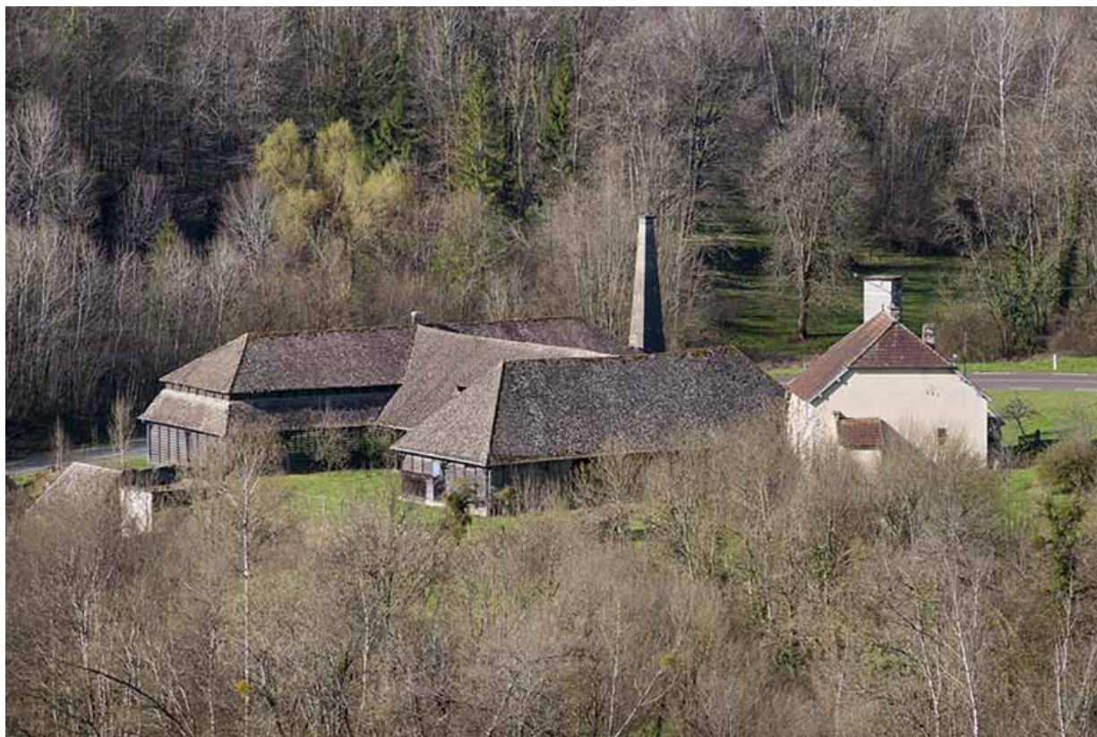
Vue plongeante depuis le nord-est.
