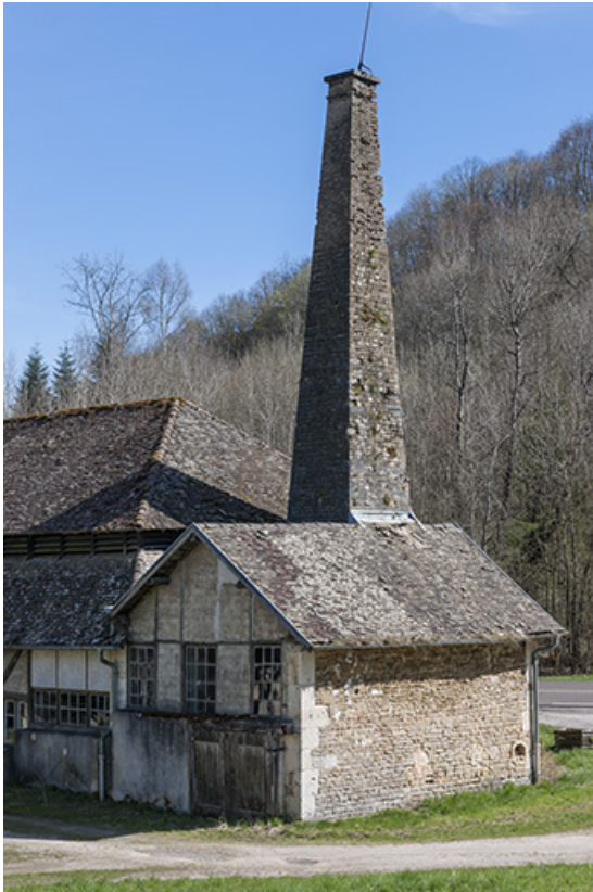
Chauferie et salle de la machine à vapeur.
