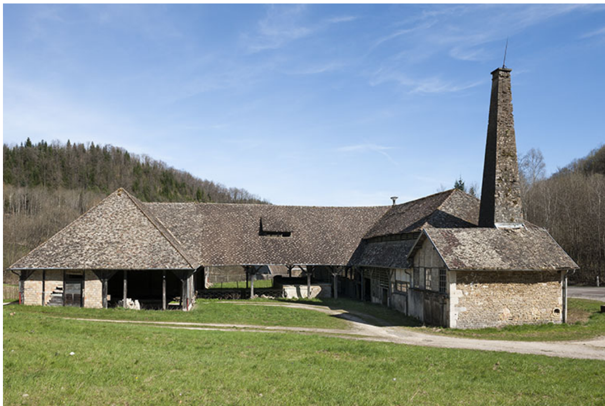
Vue rapprochée depuis l'ouest.
