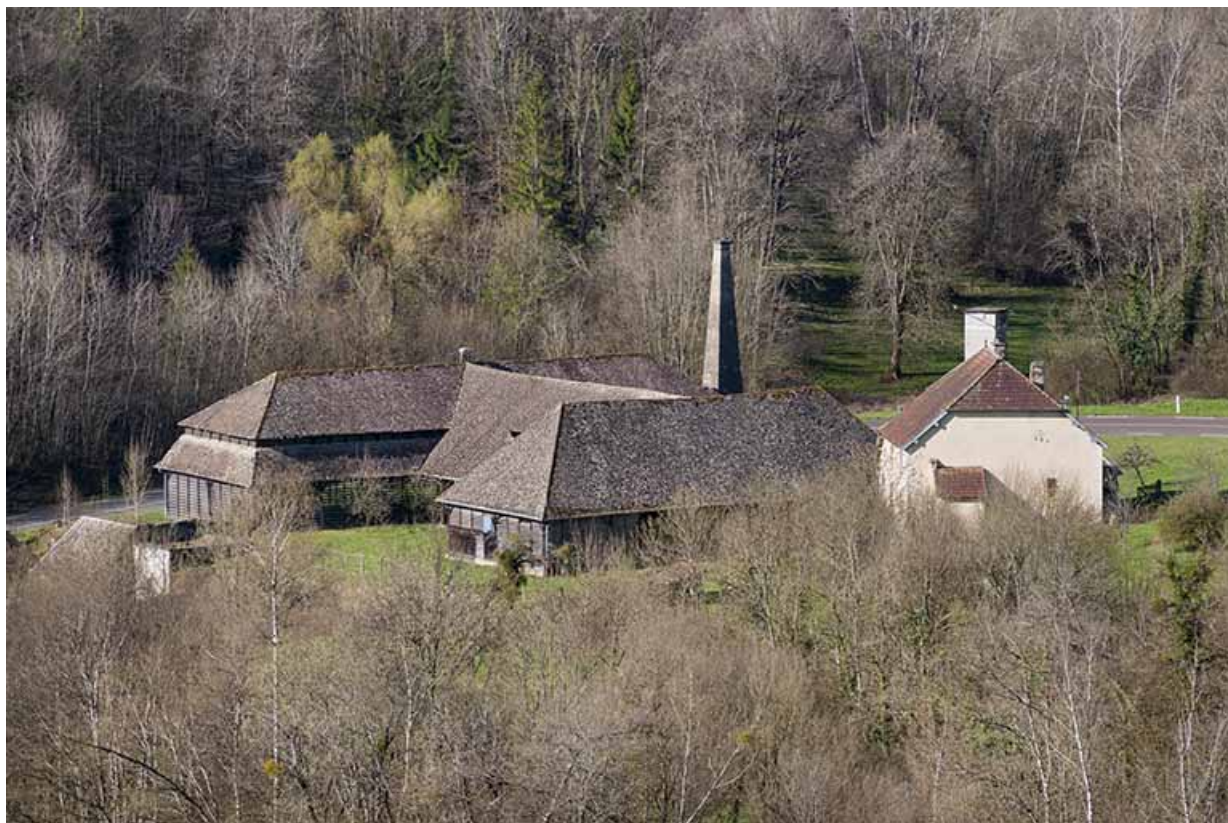
Vue plongeante depuis le nord-est.
