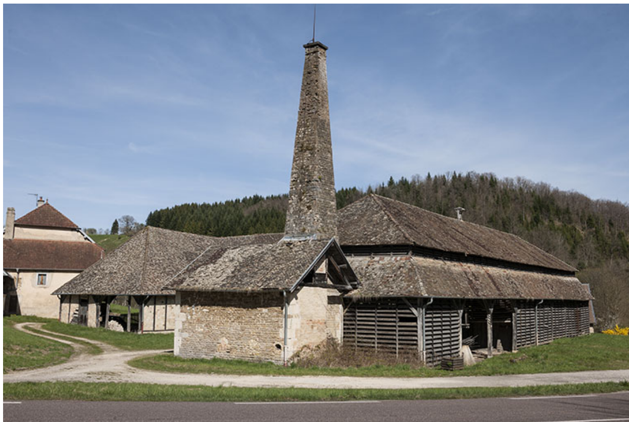
Vue rapprochée depuis le sud-ouest.
