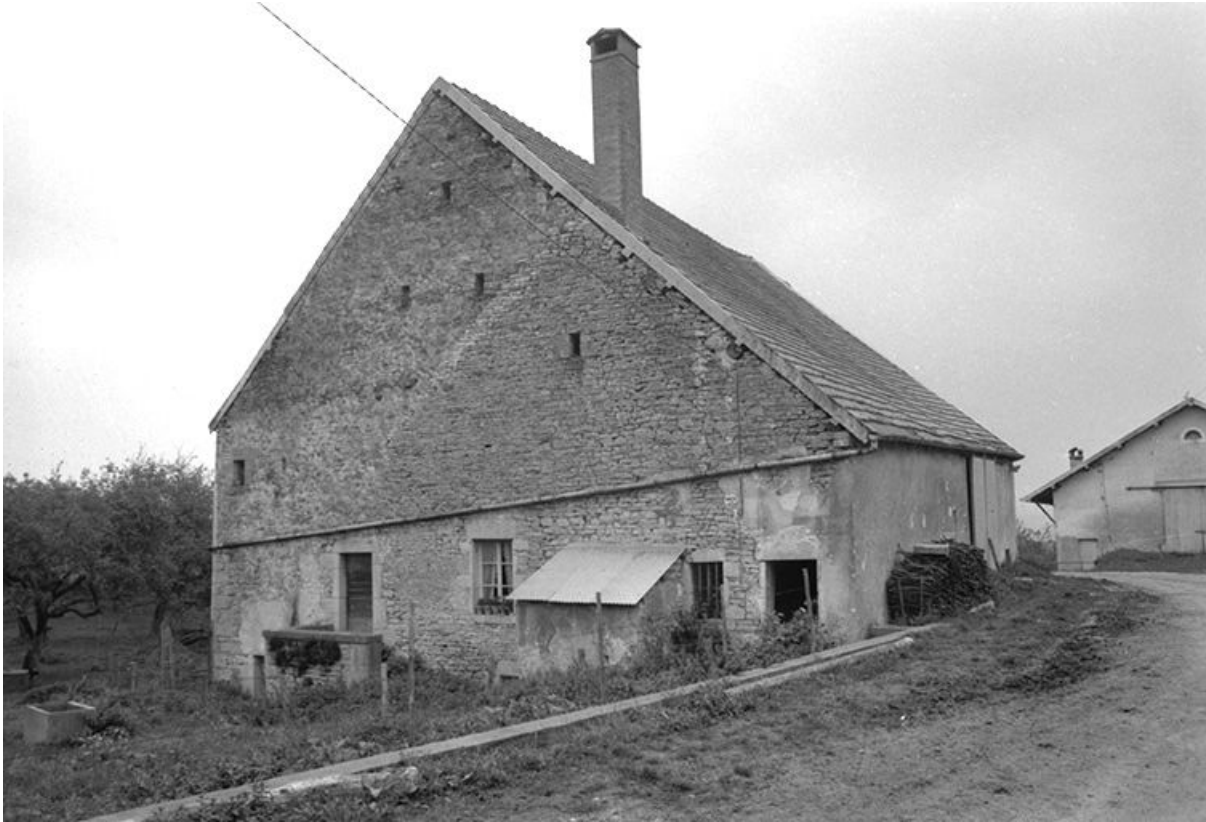
Façade antérieure et face latérale droite. 25, Malbrans
