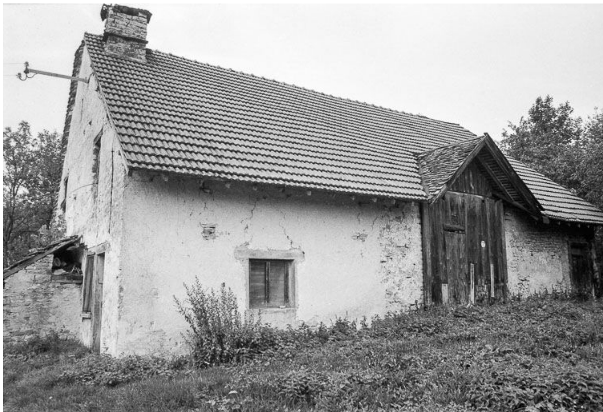
Façade latérale droite.
