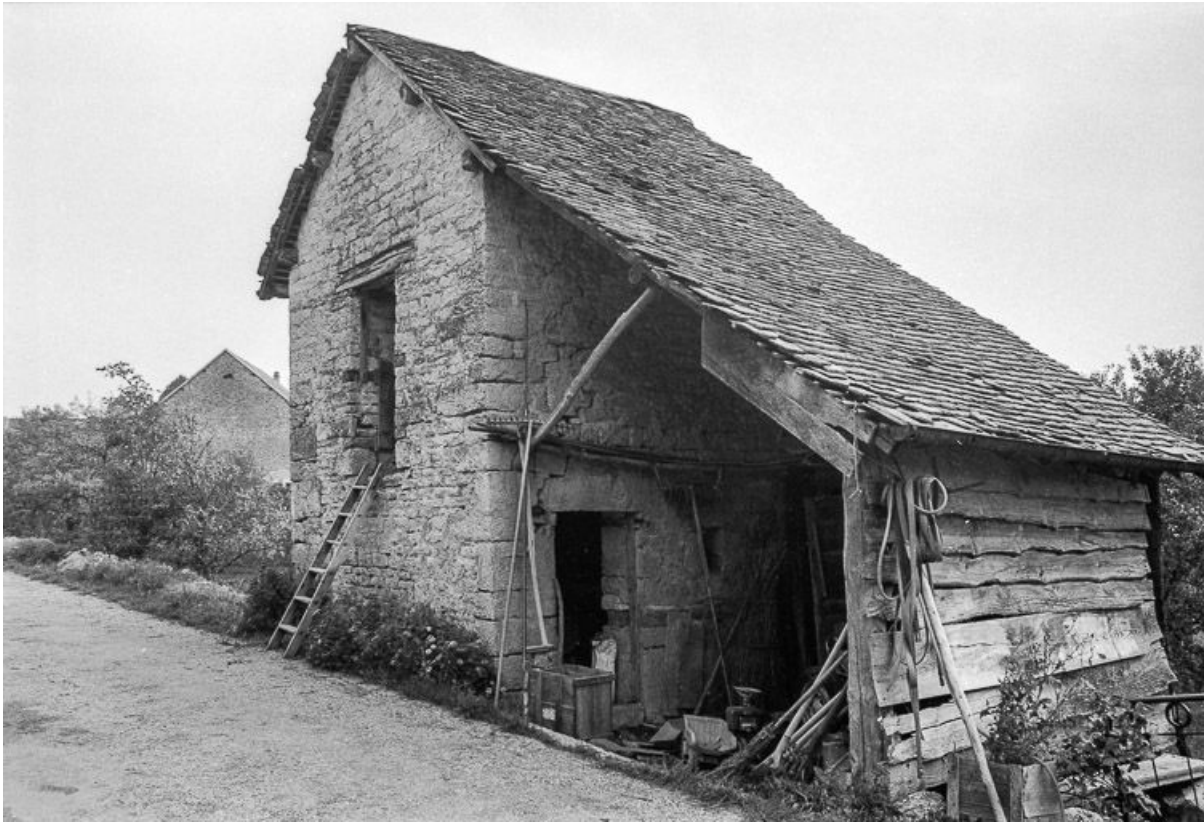
Toit à porc (soue) vue de trois quarts droit. 25, Malbrans rue des Vignes
