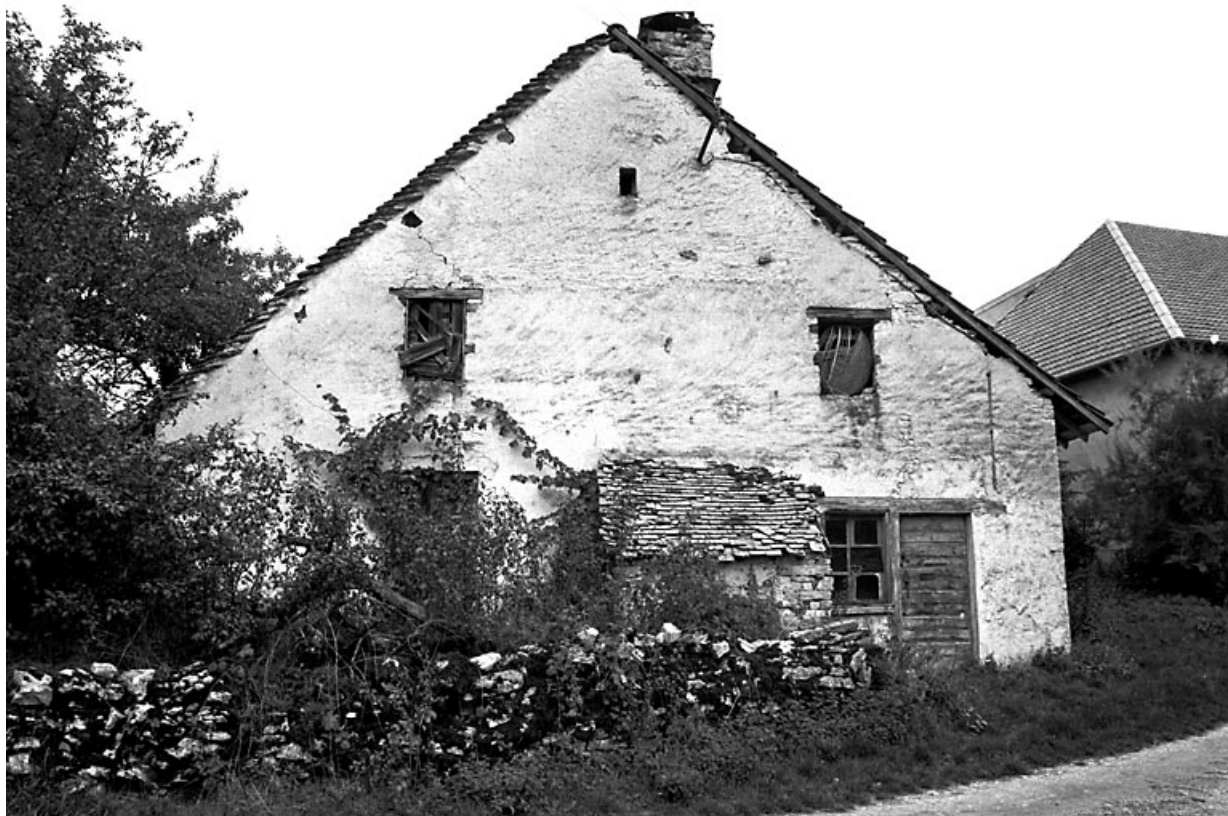
Façade antérieure. 25, Malbrans
