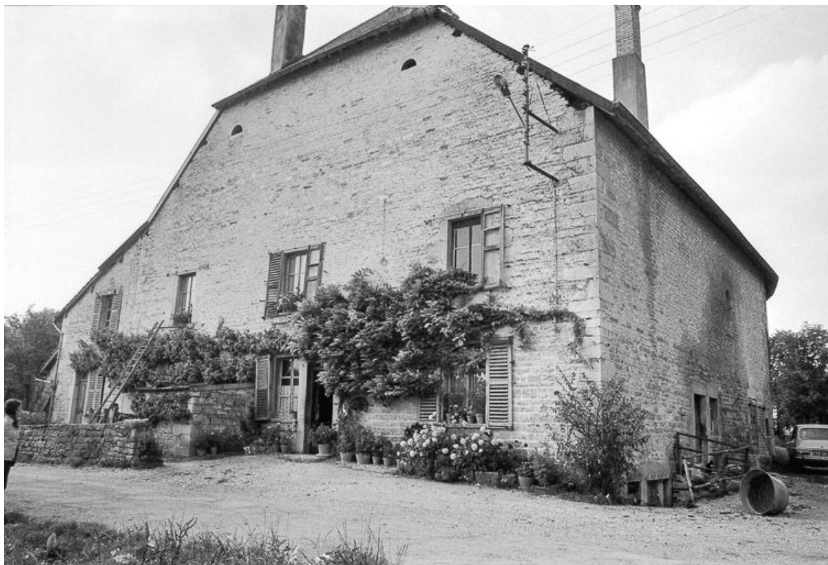
Façade antérieure. 25, Malbrans
