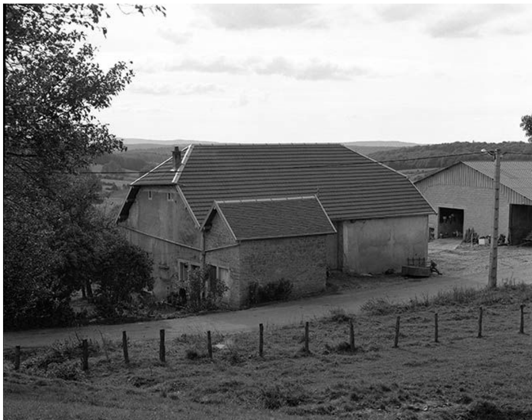
Façade antérieure et face latérale droite. 25, Malbrans
