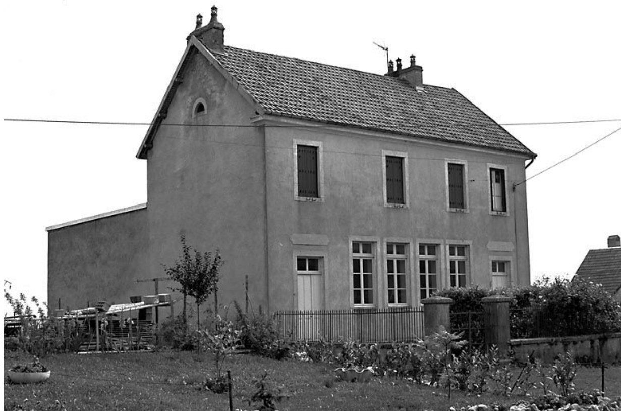
Façade antérieure et face latérale gauche. 25, Malbrans
