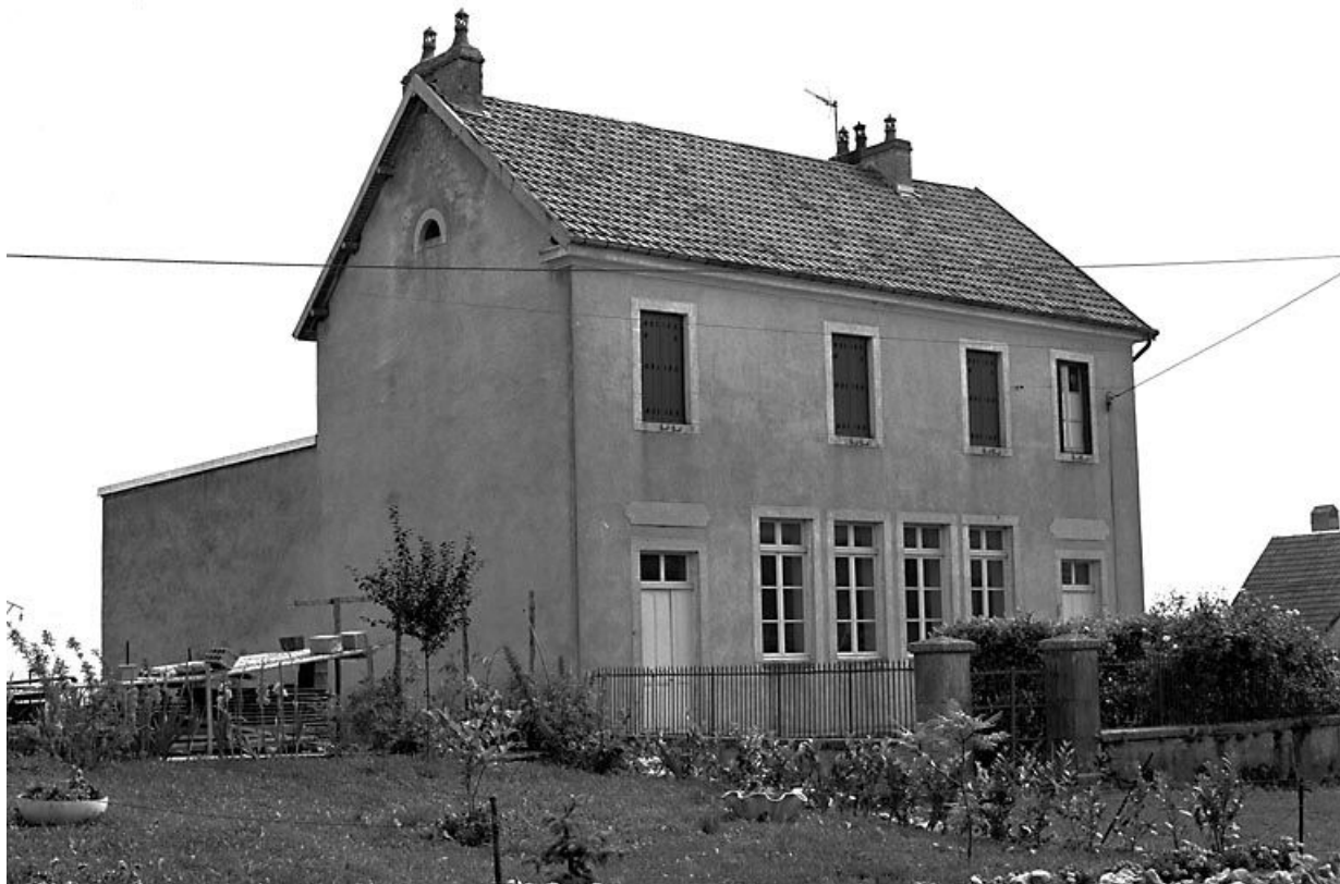
Façade antérieure et face latérale gauche. 25, Malbrans
