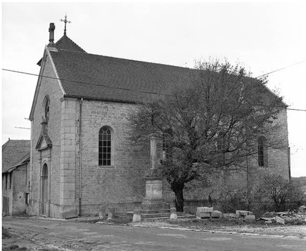
Façade antérieure et face latérale droite.
