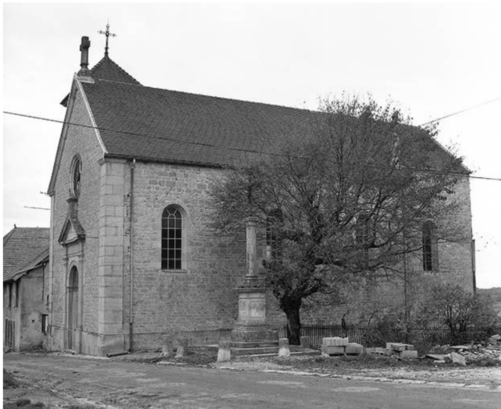
Façade antérieure et face latérale droite.
