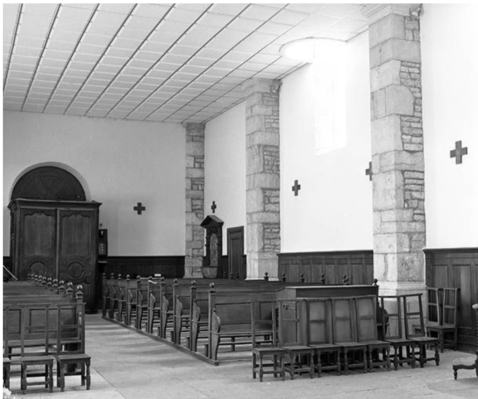
Intérieur : la nef vue depuis le chœur.
