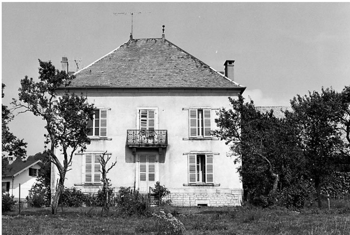
Façade postérieure du logis.
