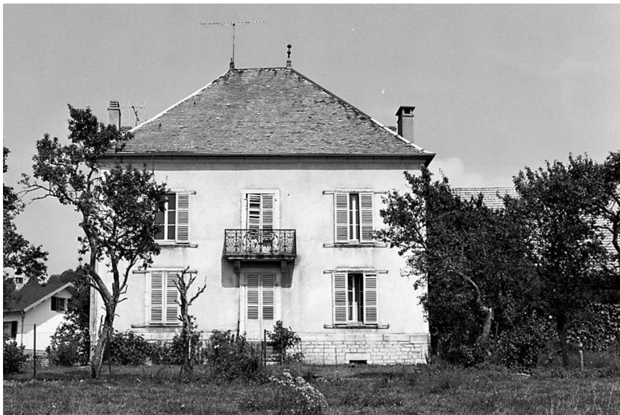
Façade postérieure du logis.
