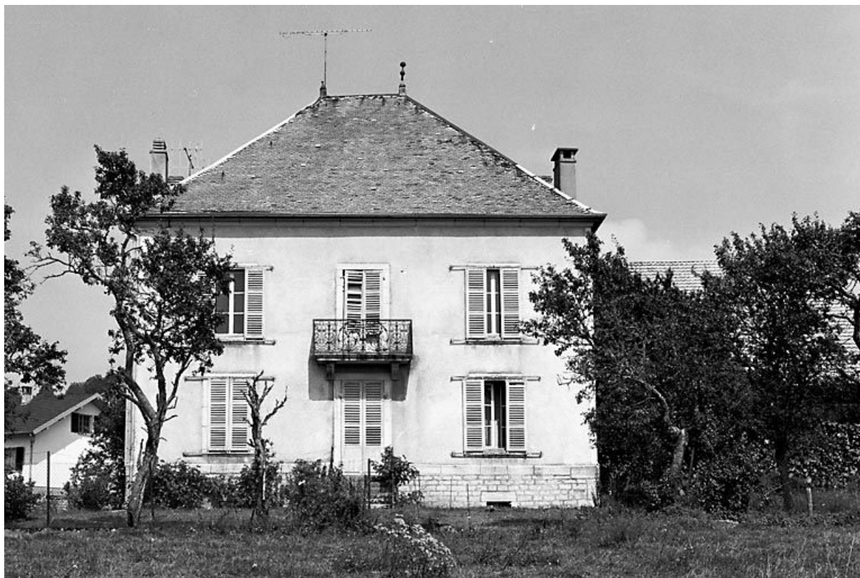
Façade postérieure du logis.
