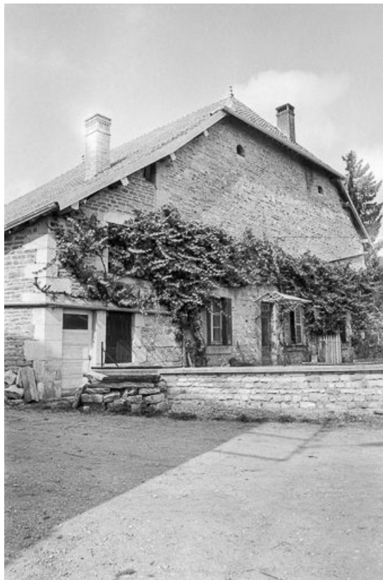
Ferme située rue des Vignes : façade antérieure. 25, Malbrans
