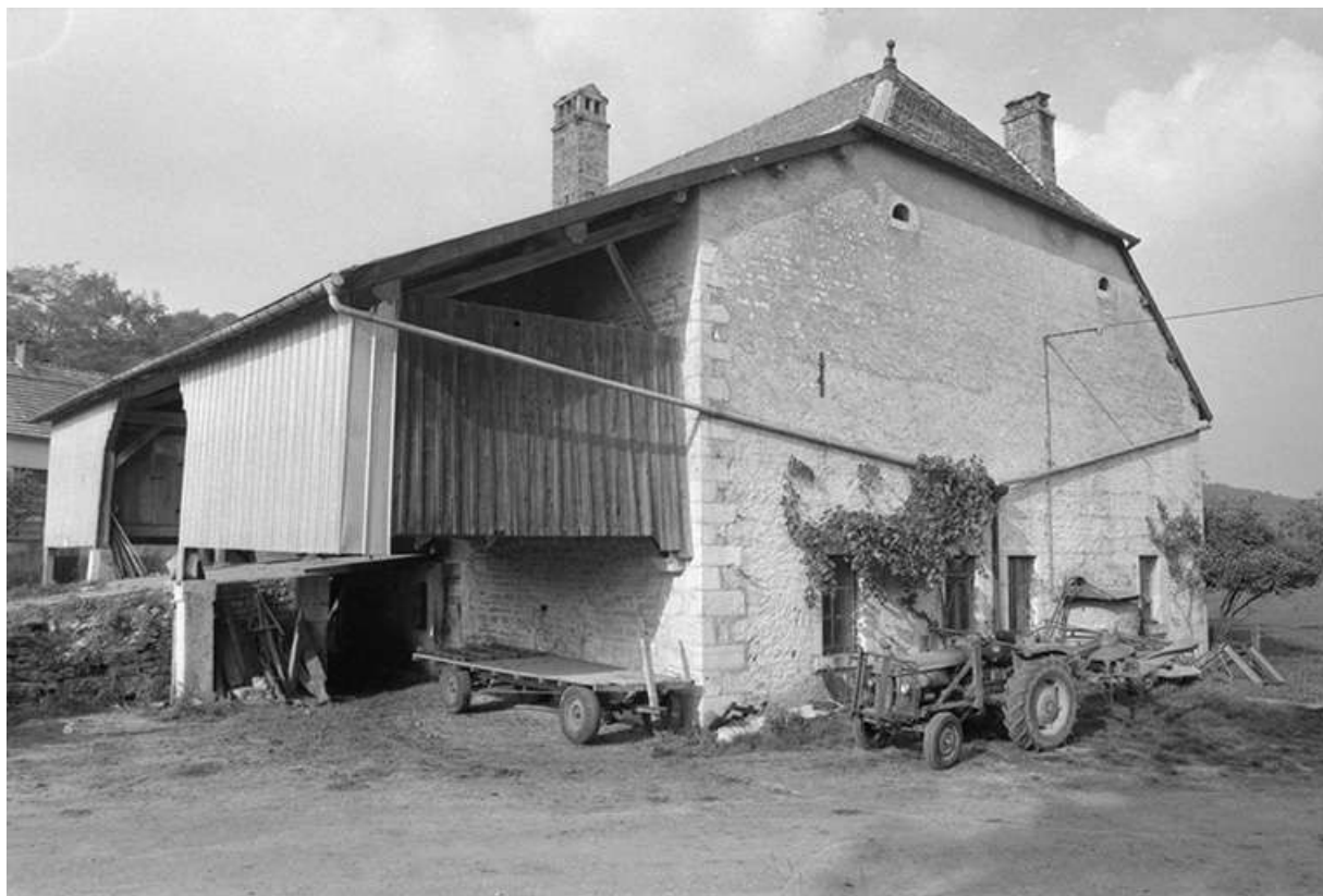
Ferme située rue des Vignes : vue générale. 25, Malbrans
