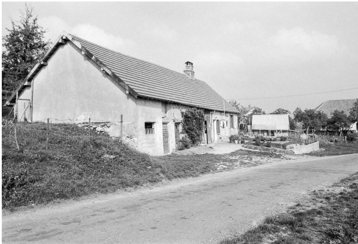
Ferme située 5 Grande Rue : vue générale. 25, Malbrans
