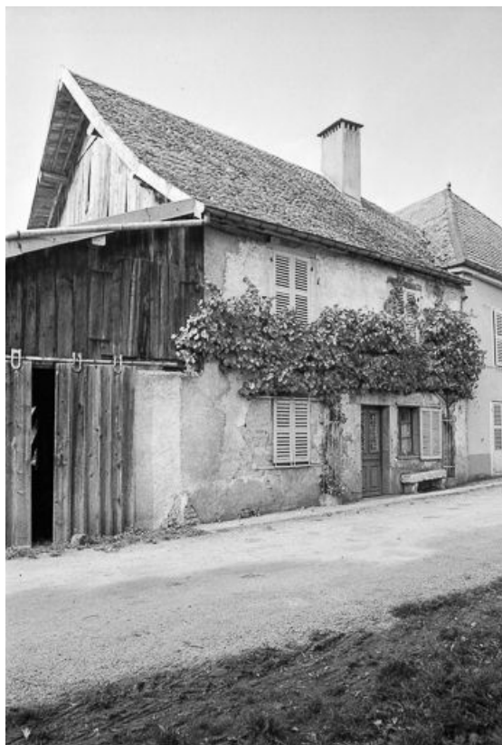
Ferme cadastrée 1971 AB 74 : vue générale. 25, Malbrans
