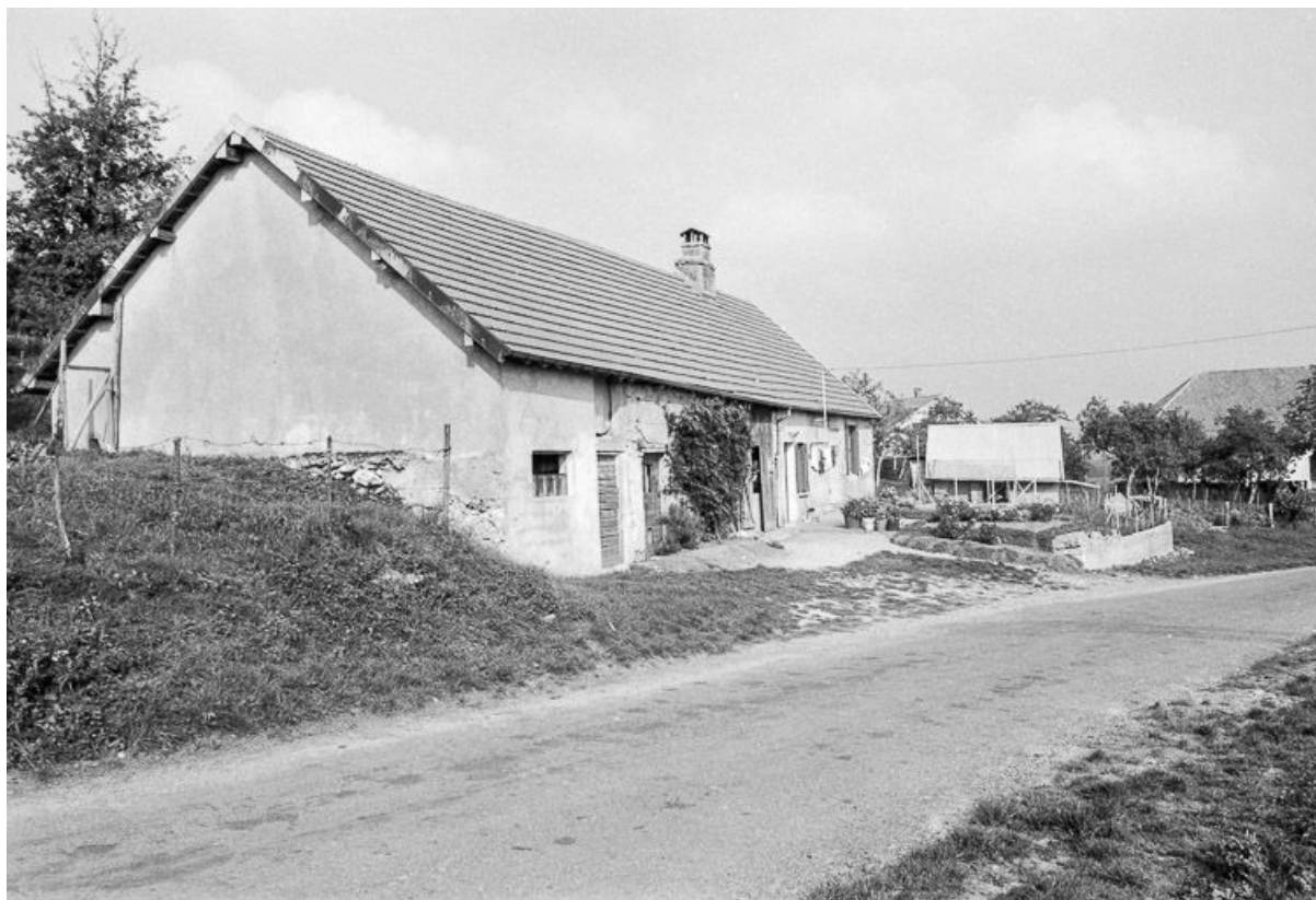
Ferme située 5 Grande Rue : vue générale. 25, Malbrans
