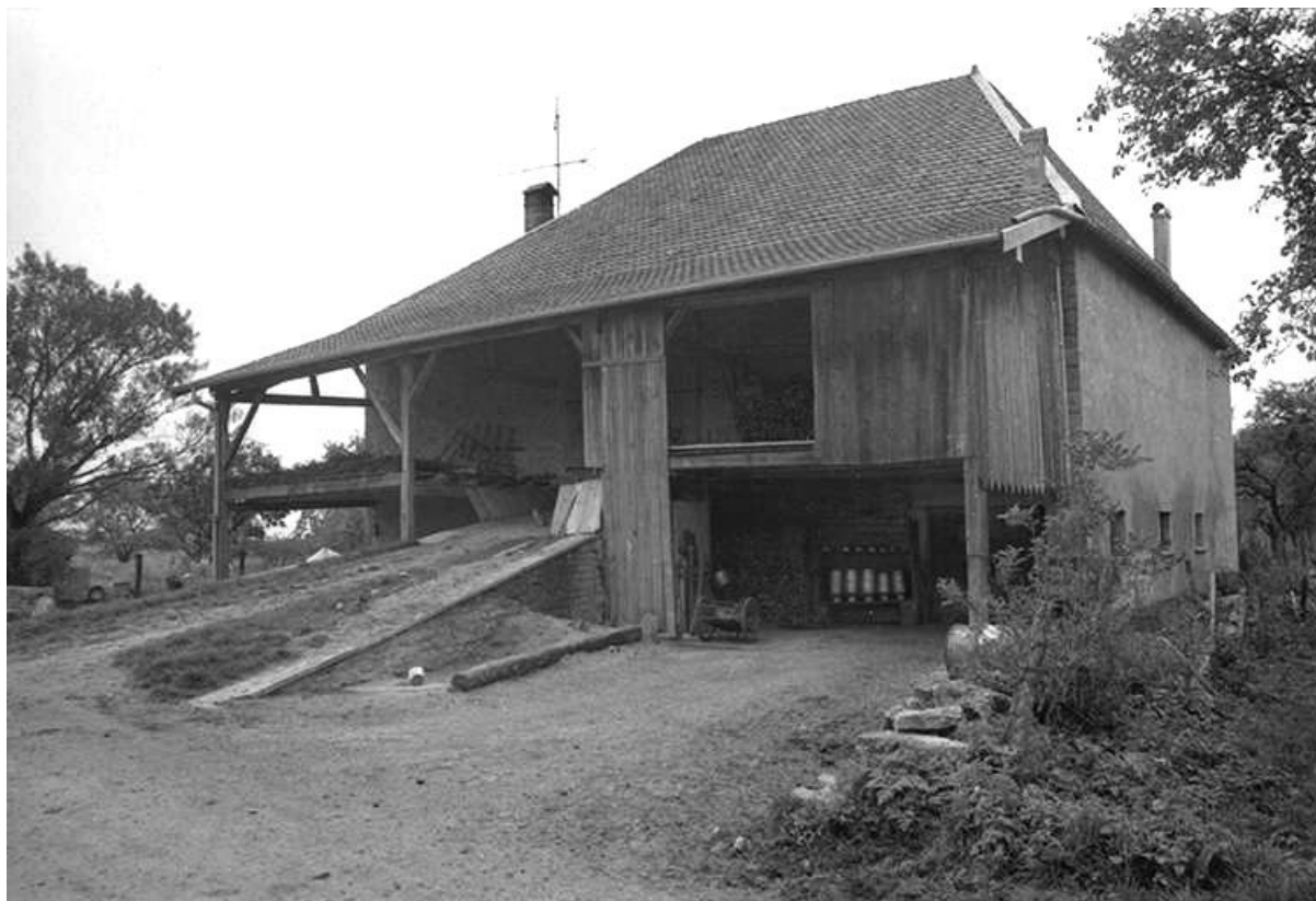
Ferme située rue du Grand Courtil : vue de trois quarts droit. 25, Malbrans
