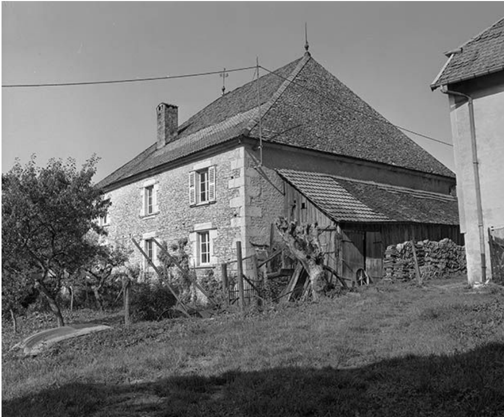
Façade postérieure vue de trois quarts droit. 25, Longeville rue du Château
