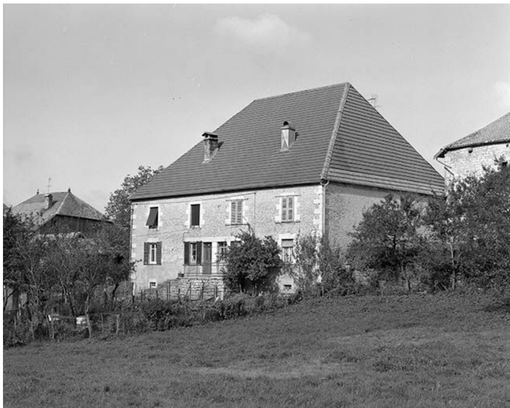
Façade postérieure et face latérale gauche.
