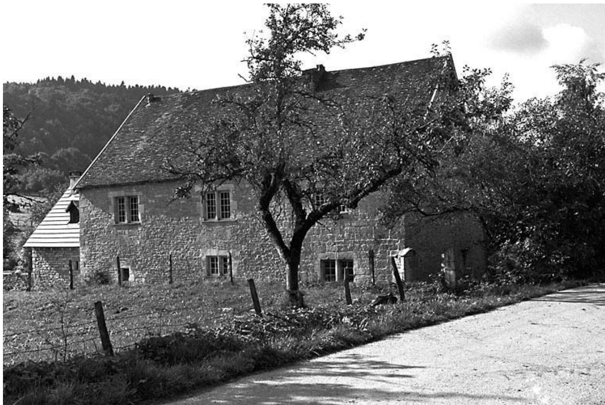
Façade postérieure vue depuis le chemin.
