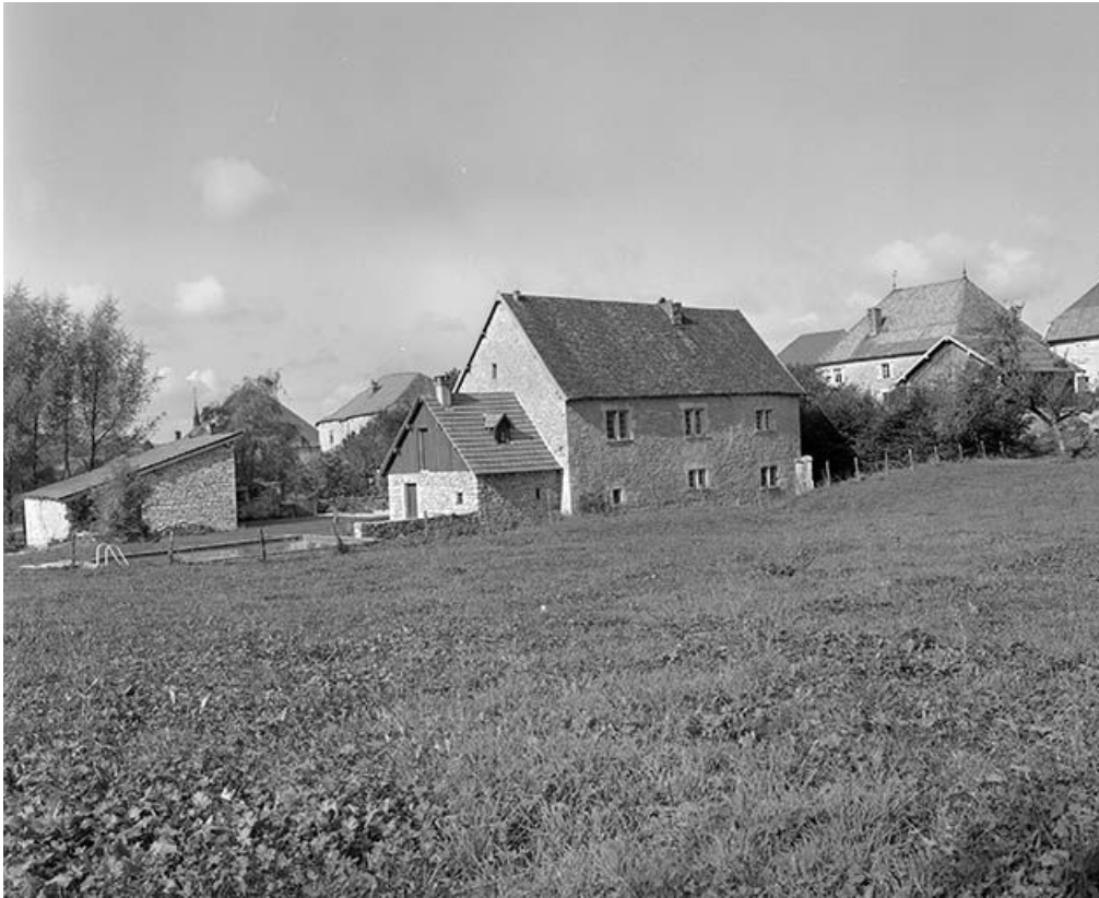
Façade postérieure vue depuis le pré. 25, Longeville rue du Château
