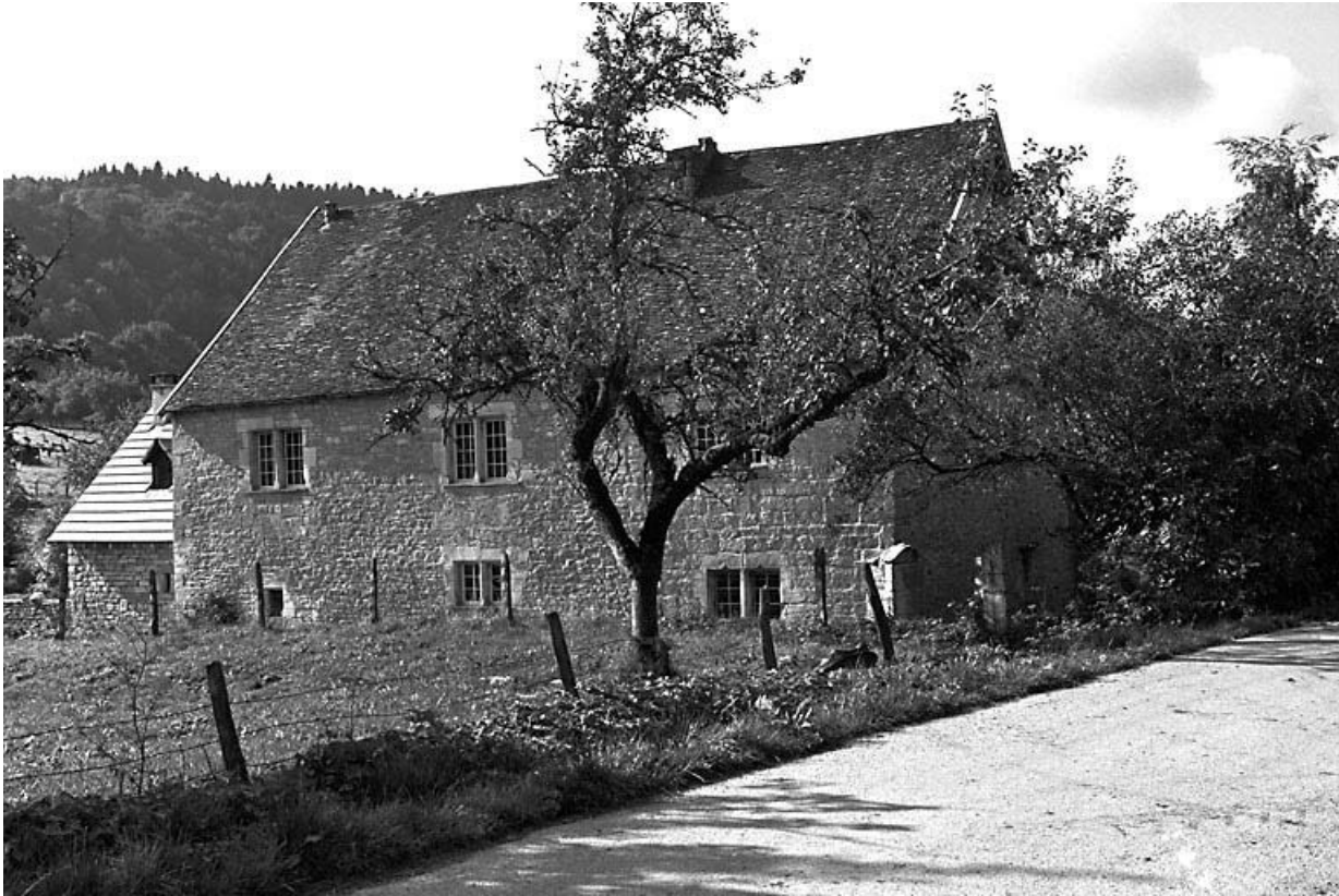
Façade postérieure vue depuis le chemin.
