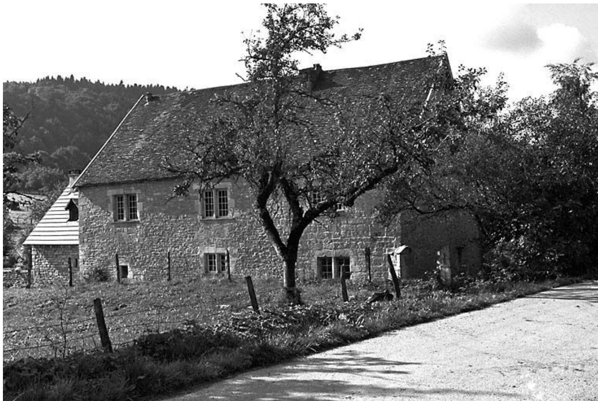
Façade postérieure vue depuis le chemin.
