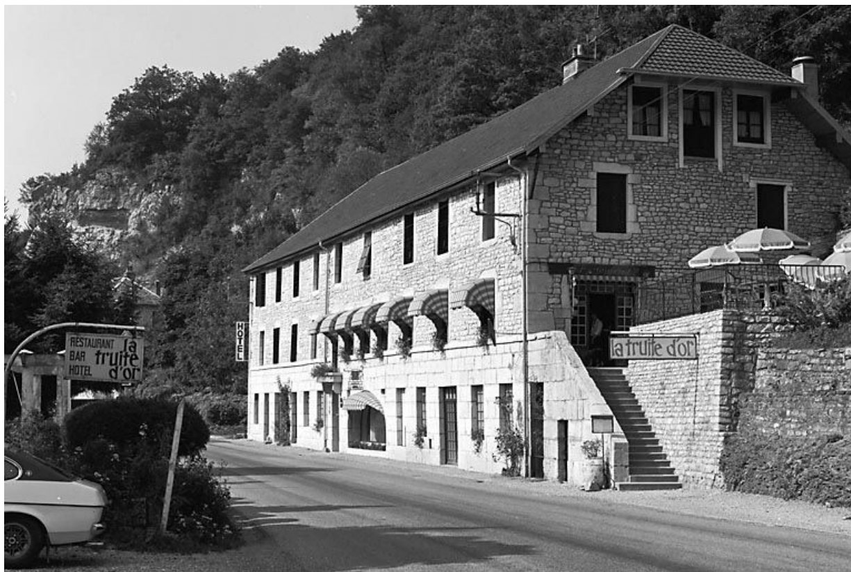
Façade antérieure de trois quarts droit. 25, Lods
