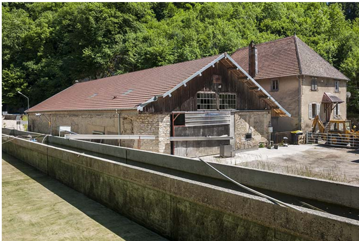
Atelier de scierie et logement vus de trois quarts.
