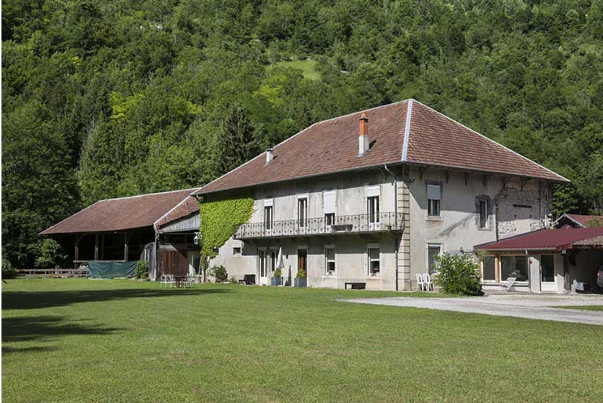
Logement patronal vu de trois quarts droite. 25, Lods, 41 route de Besançon
