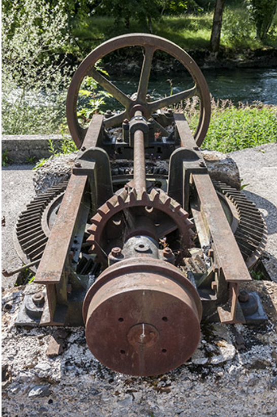
Départ de la transmission de la turbine.
