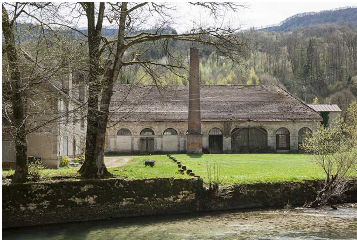
Façade nord de l'atelier de fabrication.
