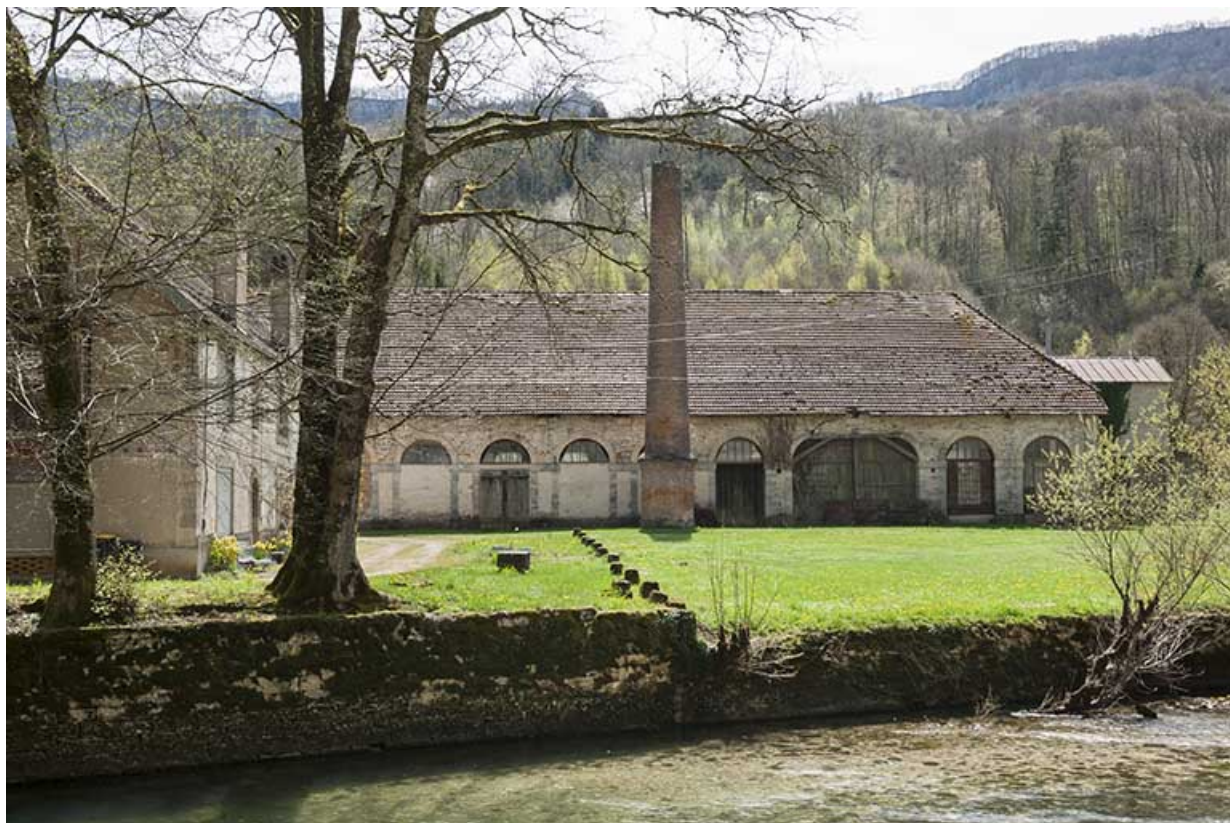
Façade nord de l'atelier de fabrication.
