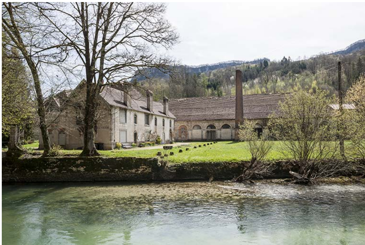
Logement et atelier depuis le nord.
