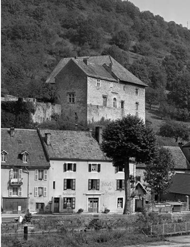
Vue générale, angle sud-ouest.
