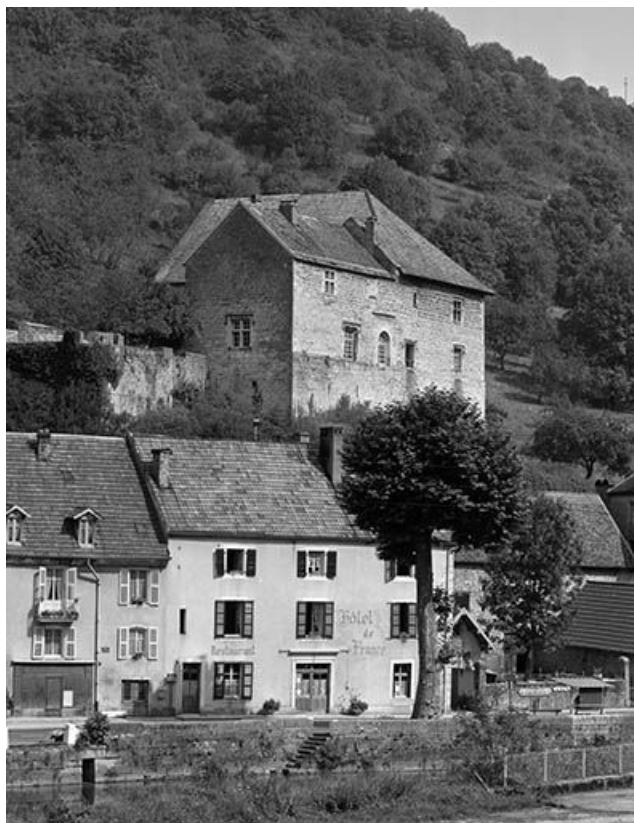
Vue générale, angle sud-ouest.
