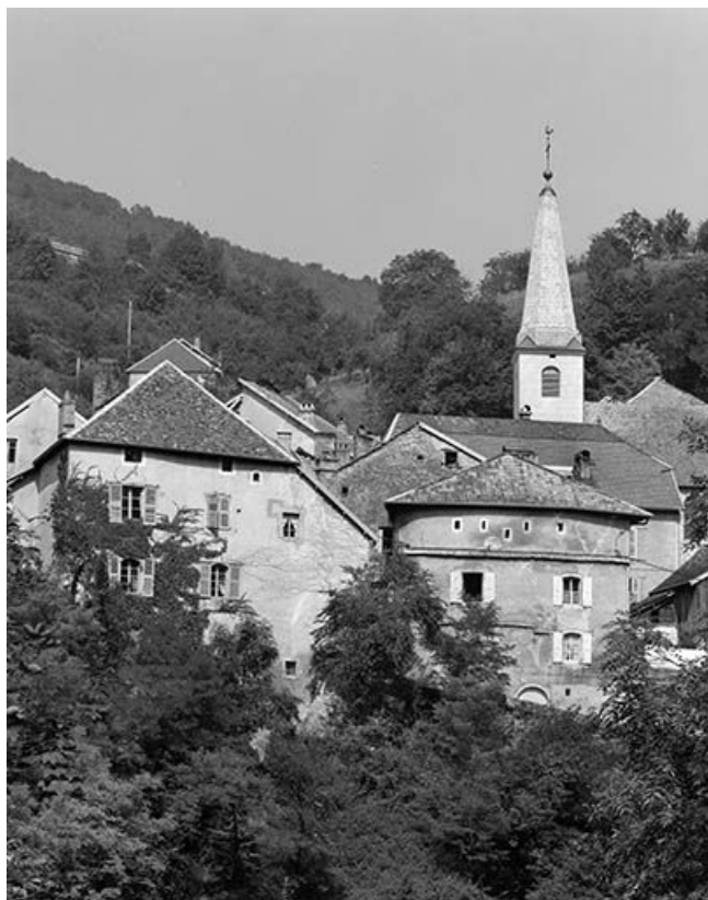
Vue générale du site depuis le sud.
