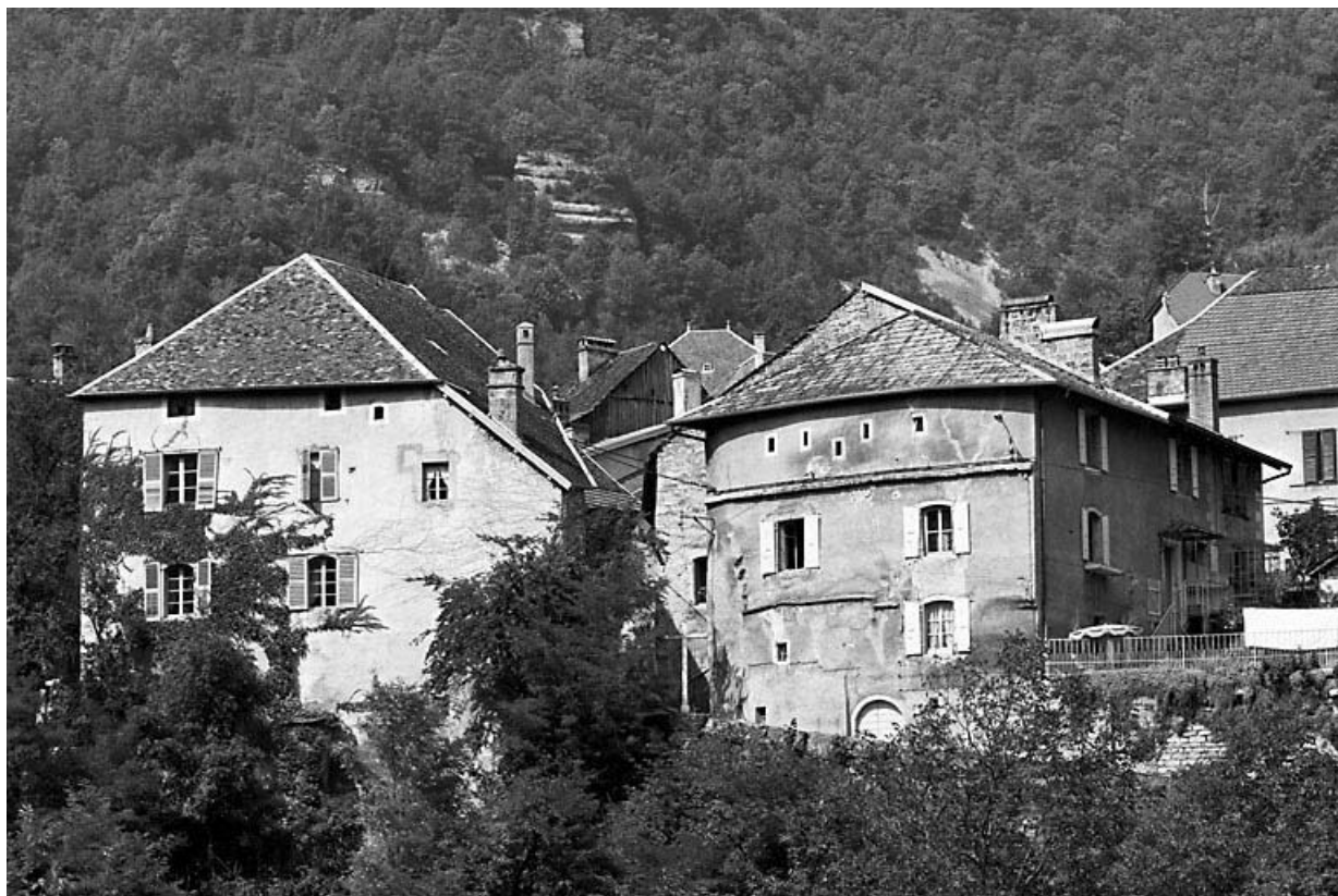
Élévation depuis le sud.
