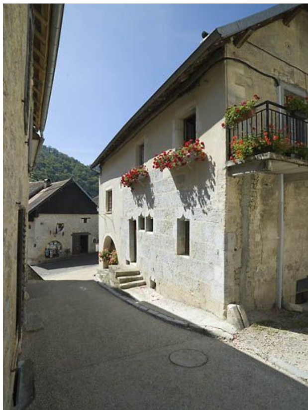
Façade antérieure vue de trois quarts droit. 25, Lods rue de l' Eglise
