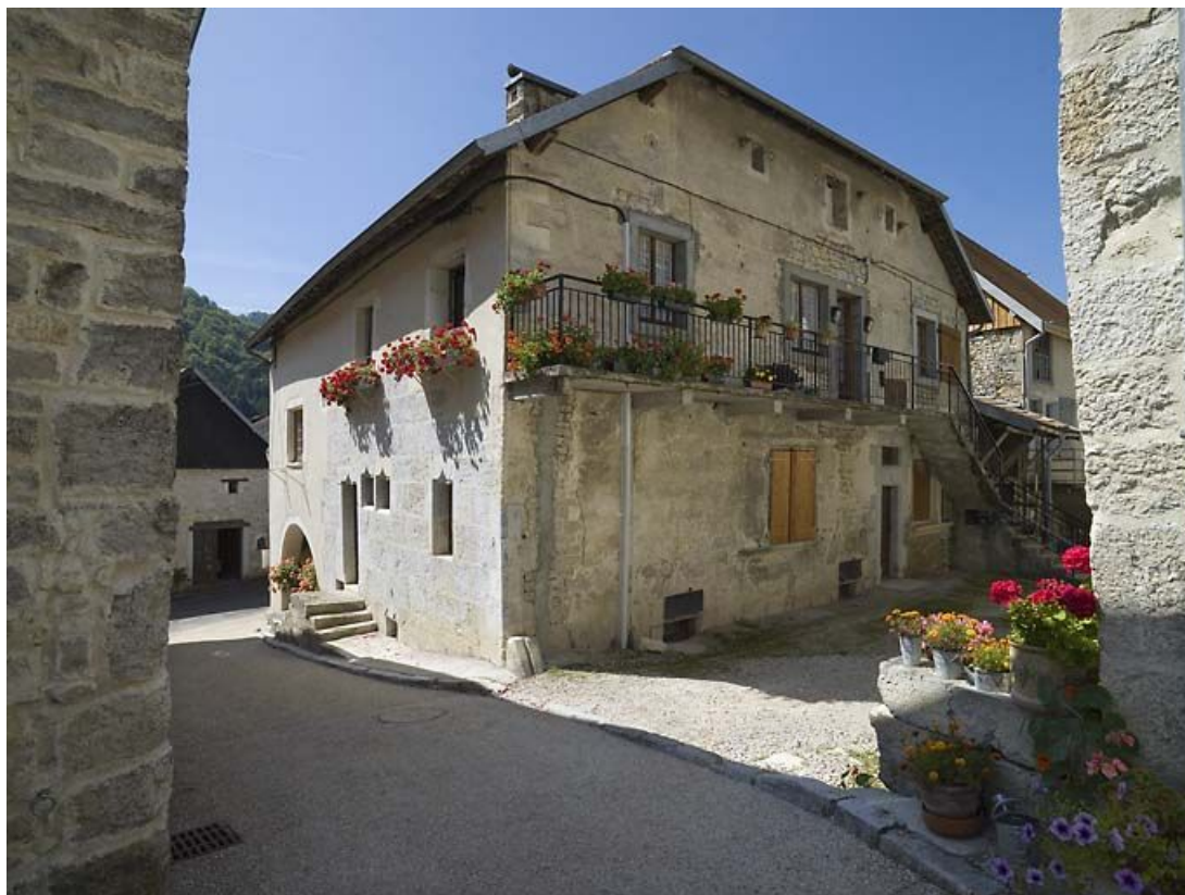
Façades antérieure et latérale droite.
