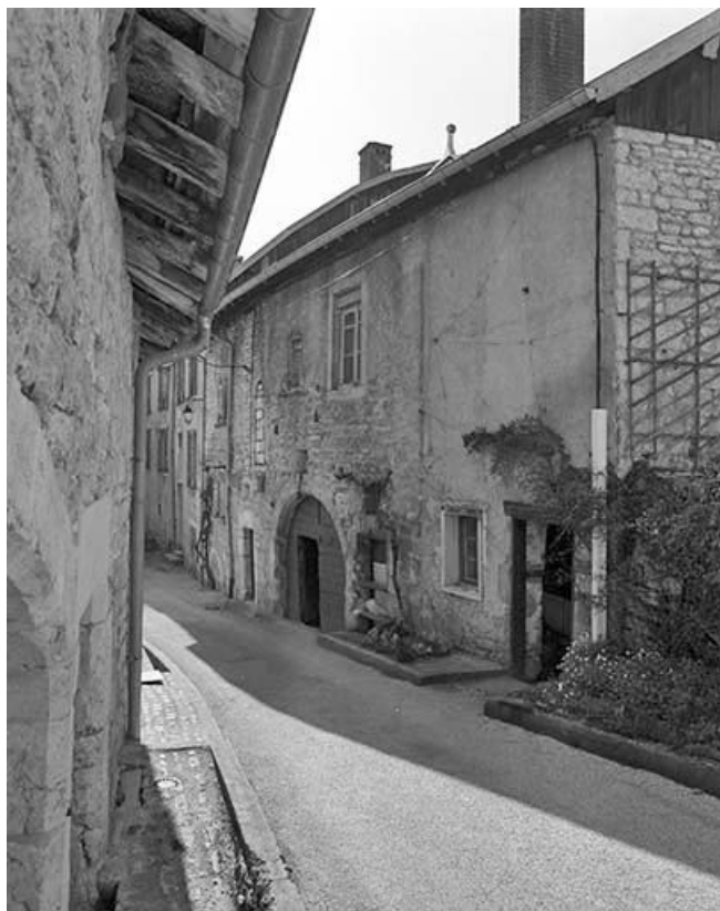
Façade antérieure de trois quarts droit.
