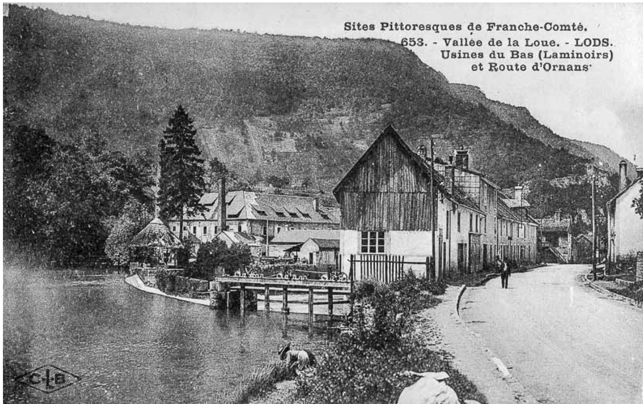
Vallée de la Loue. Lods. Usines du Bas (Laminoirs), 1ère moitié 20e siècle. 25, Lods chemin des Forges
