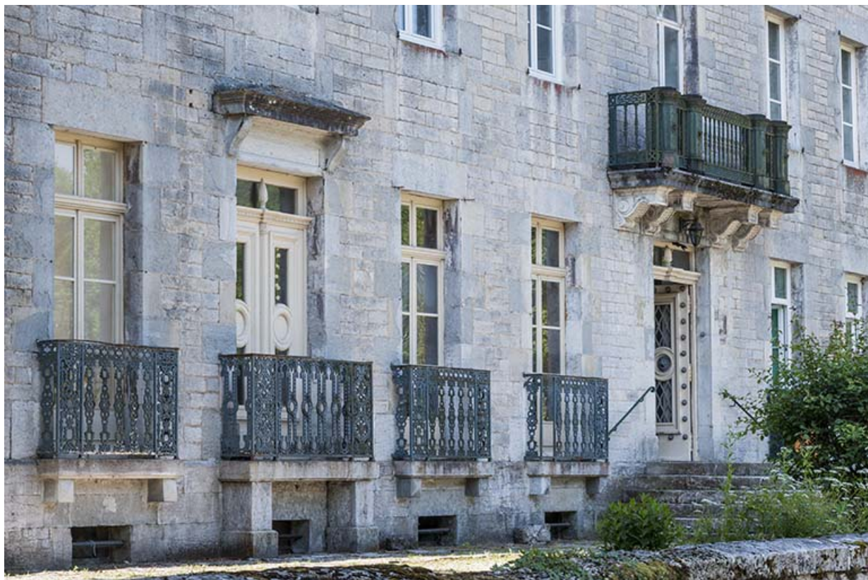
Détail de la façade du logement patronal.
