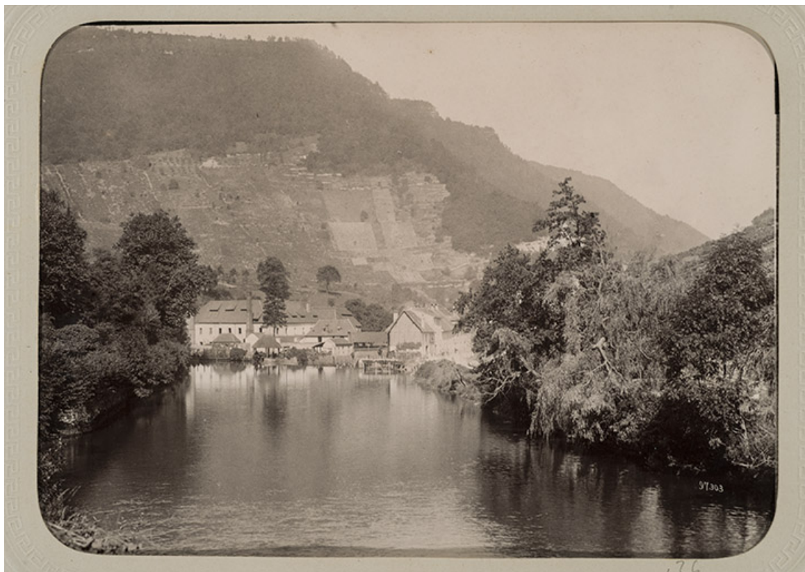
L'usine du Moulin-Neuf depuis l'amont, fotogr. De Jongh Frères, 1899-1900. 25, Lods chemin des Forges
