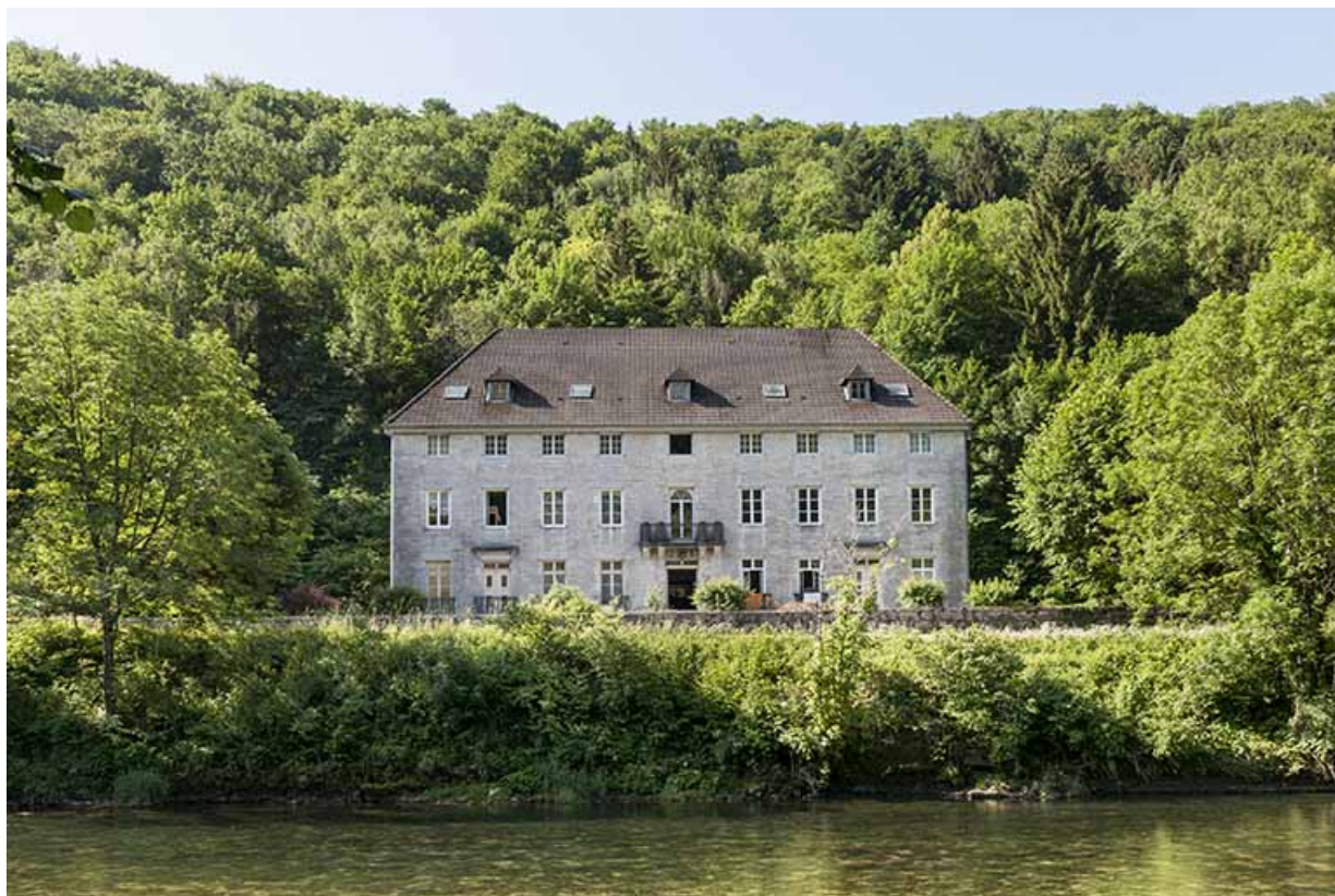
Façade antérieure du logement patronal.
