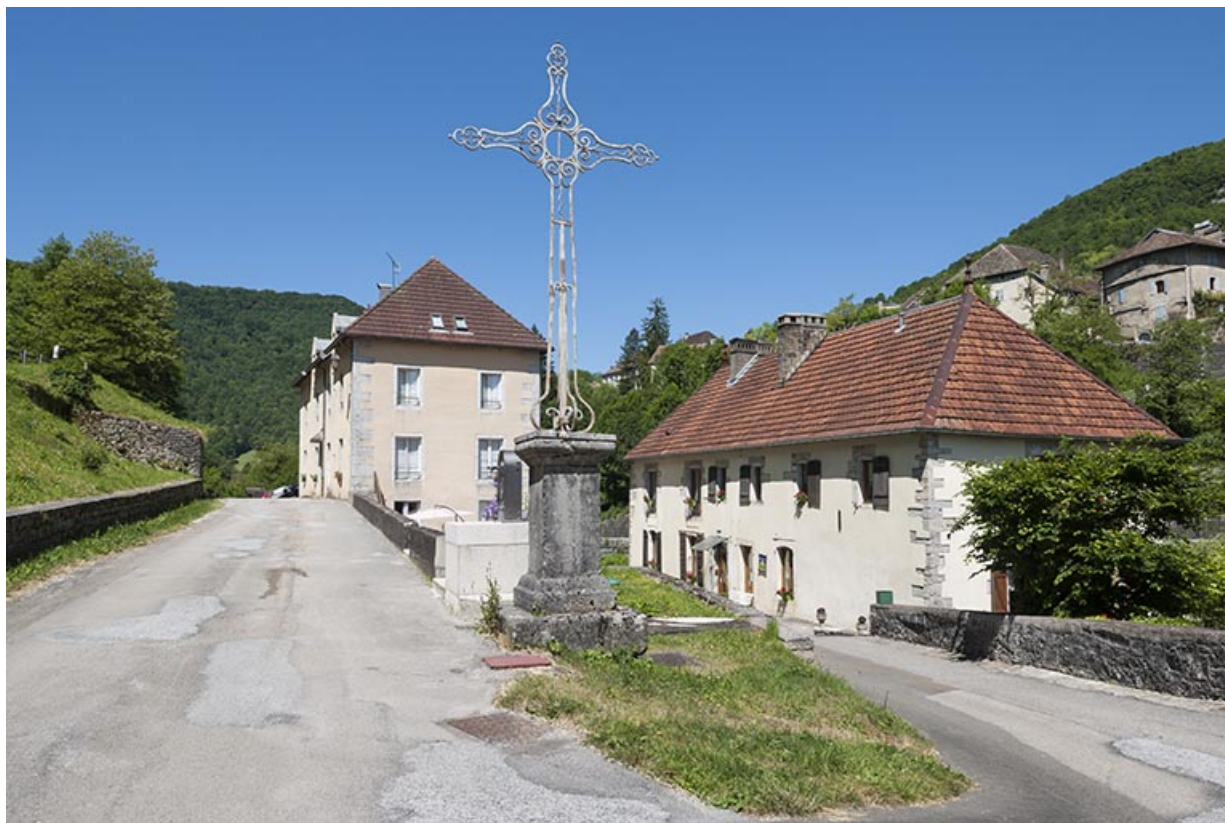
Logements d'ouvriers vus depuis l'est. 25, Lods chemin des Forges
