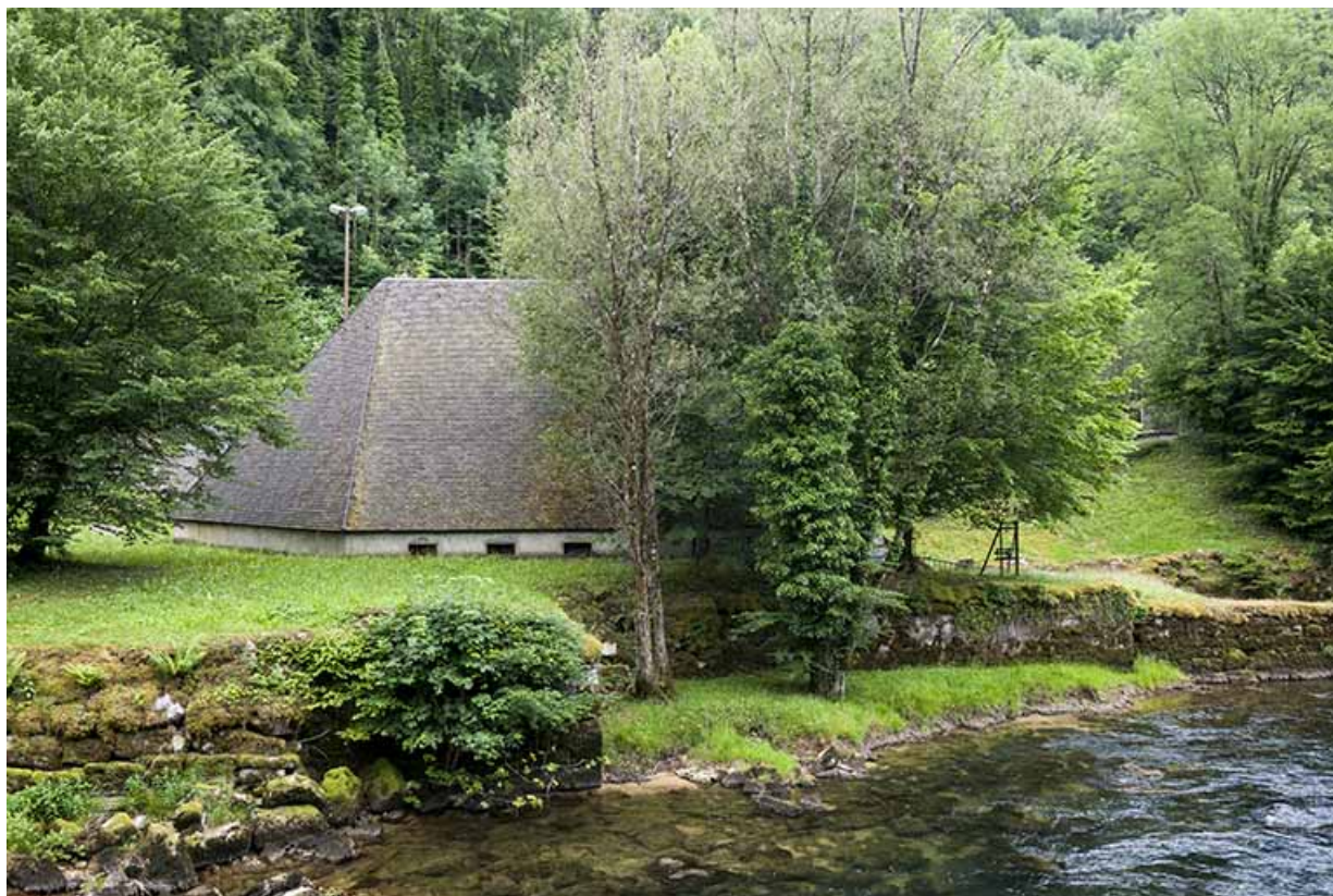
La centrale hydroélectrique vue depuis la rive droite.
