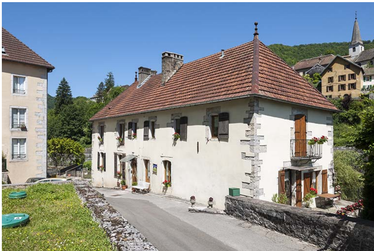
Logement d'ouvriers vue de trois quarts.
