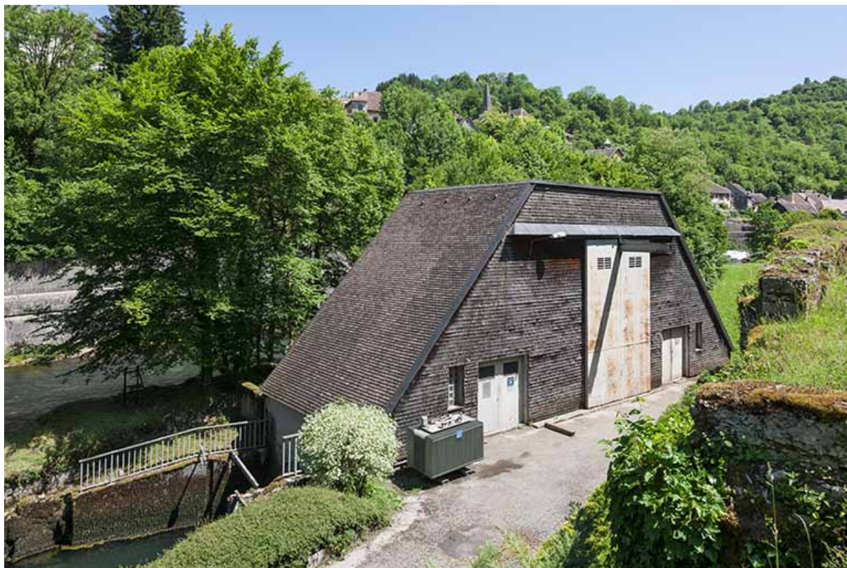
La centrale hydroélectrique vue de trois quarts.
