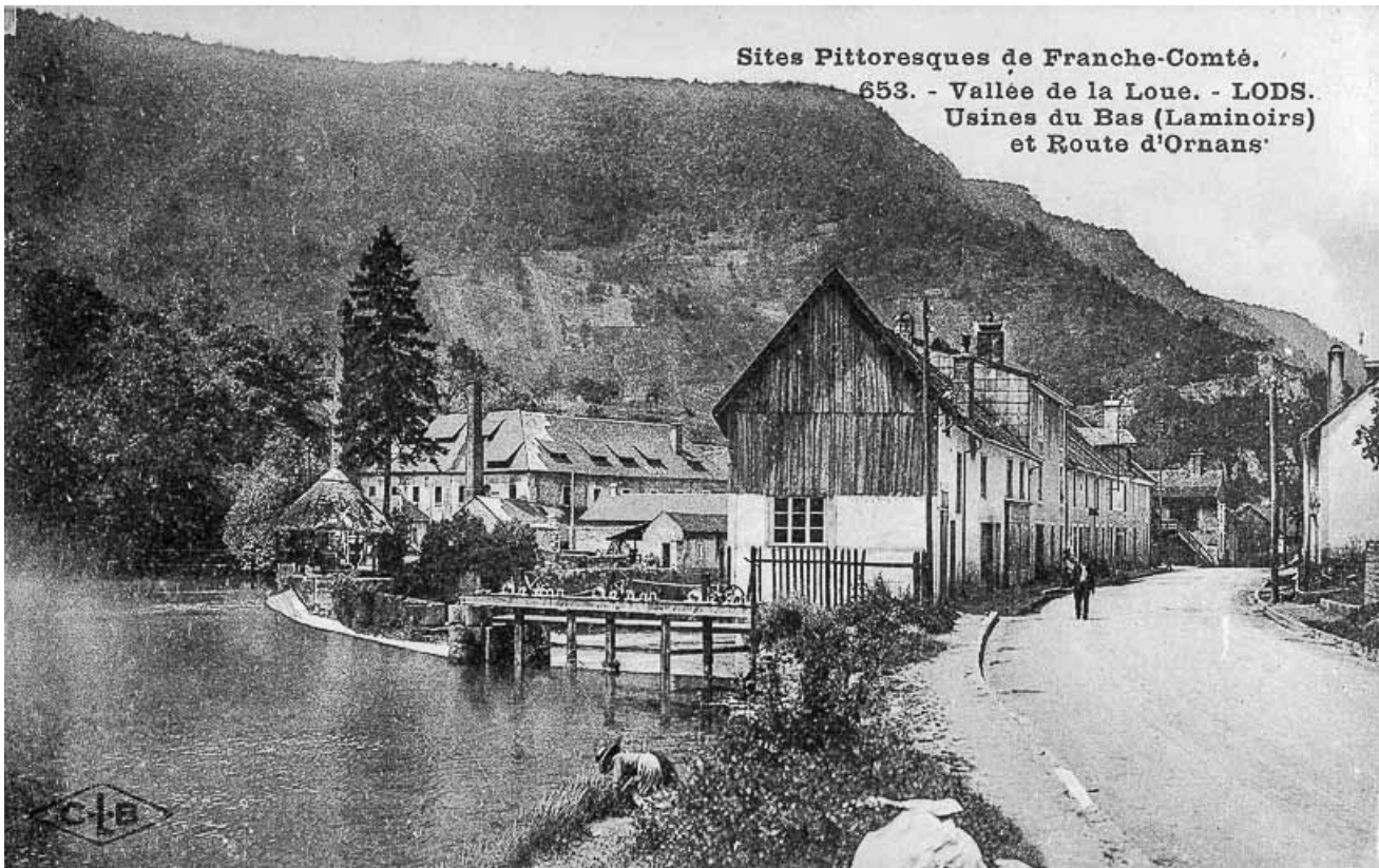
Vallée de la Loue. Lods. Usines du Bas (Laminoirs), 1ère moitié 20e siècle. 25, Lods chemin des Forges
