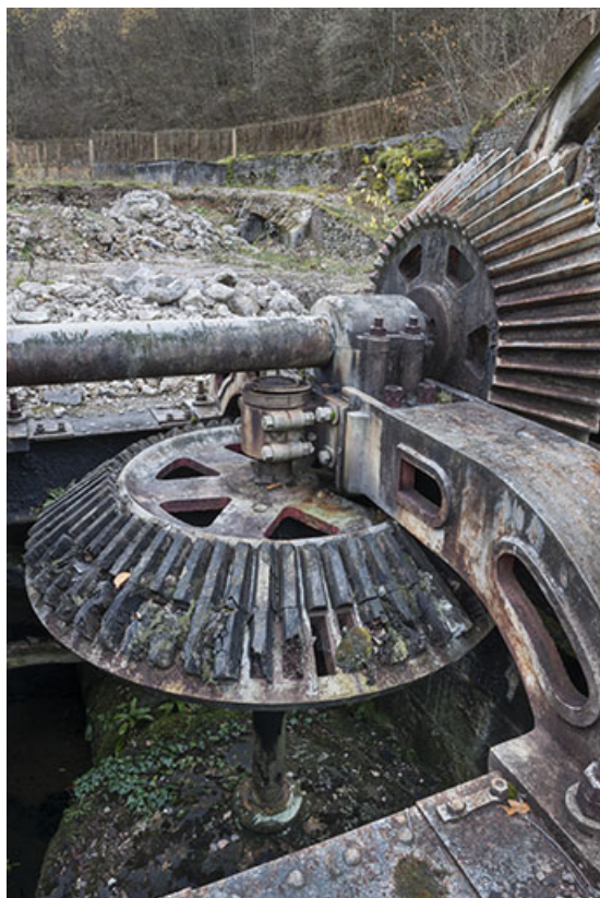
Turbine double. Détail des engrenages coniques. 25, Lods chemin des Forges
