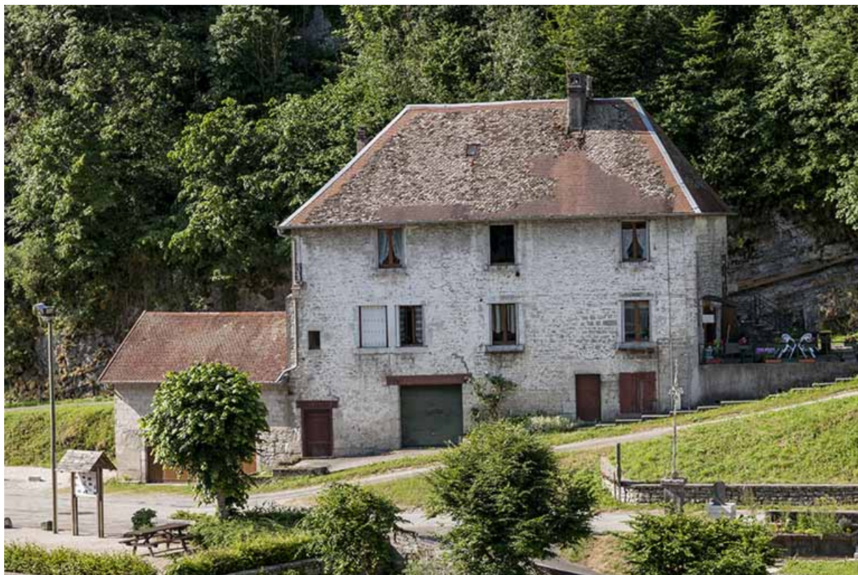
Logements d'ouvriers (route de Longeville). 25, Lods chemin des Forges
