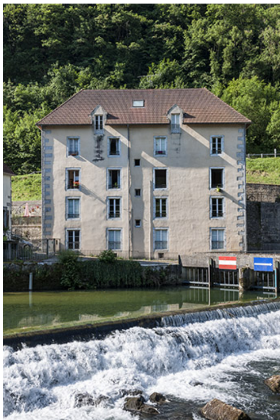
Façade nord d'un logement d'ouvriers. 25, Lods chemin des Forges
