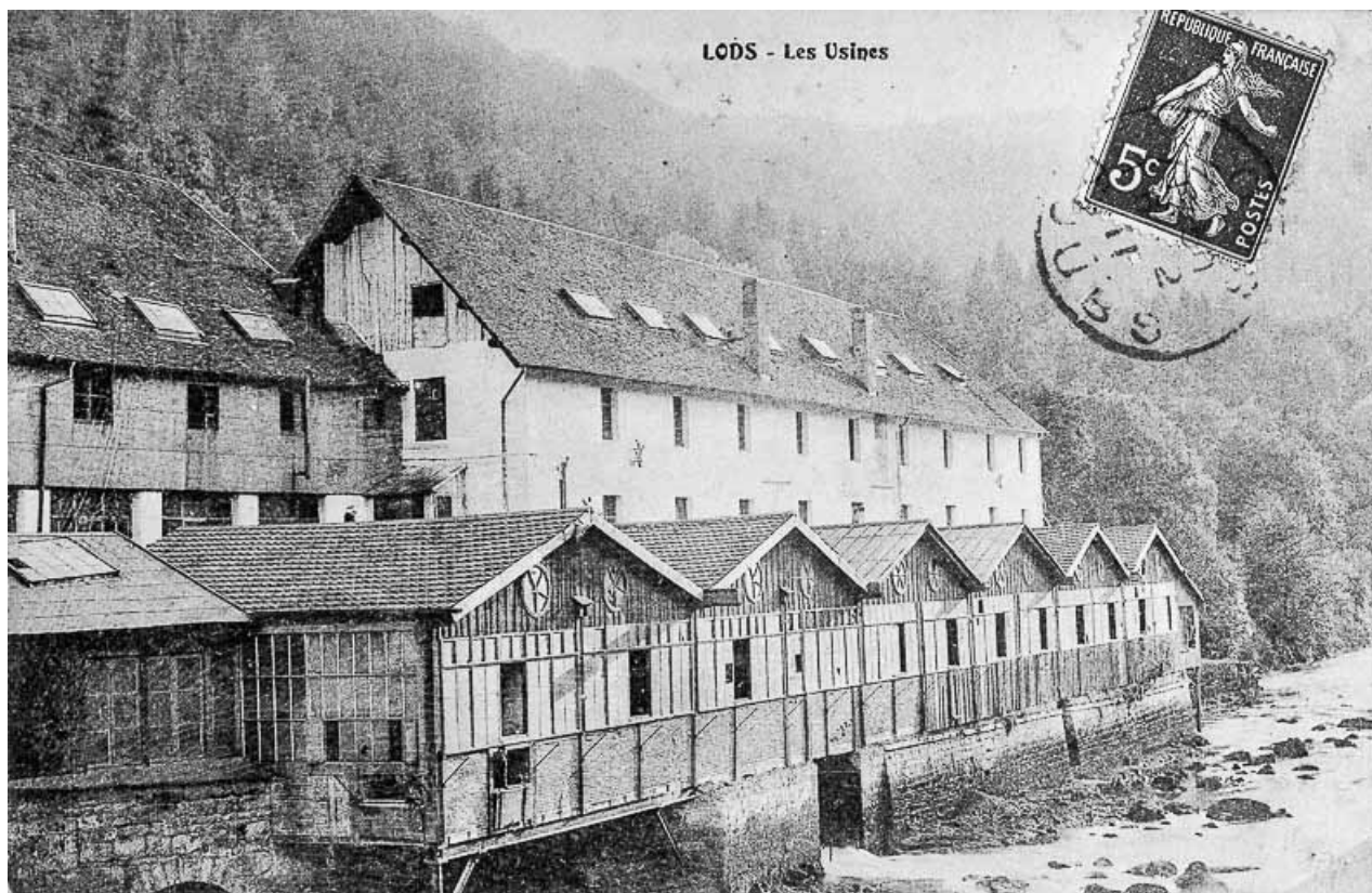
Lods - Les Usines, 1911. 25, Lods chemin des Forges
