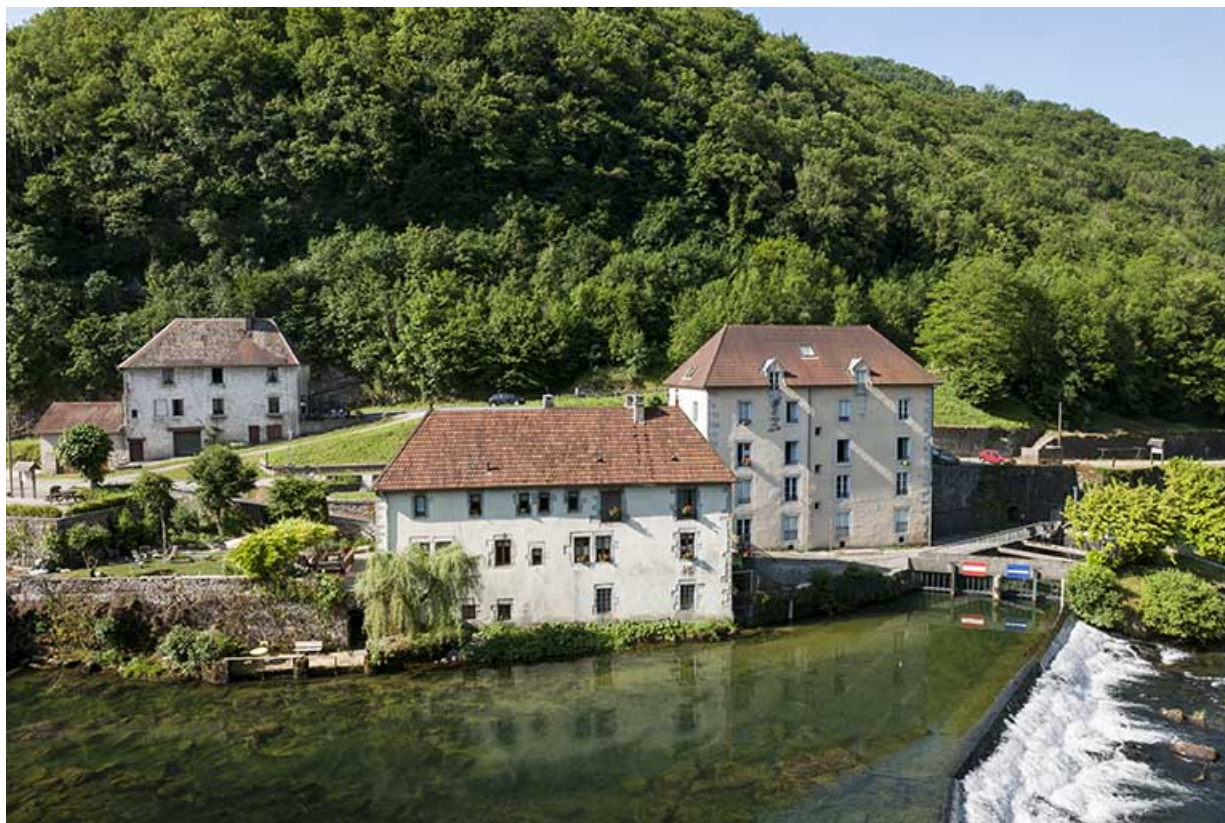
Logements d'ouvriers, depuis le nord.
