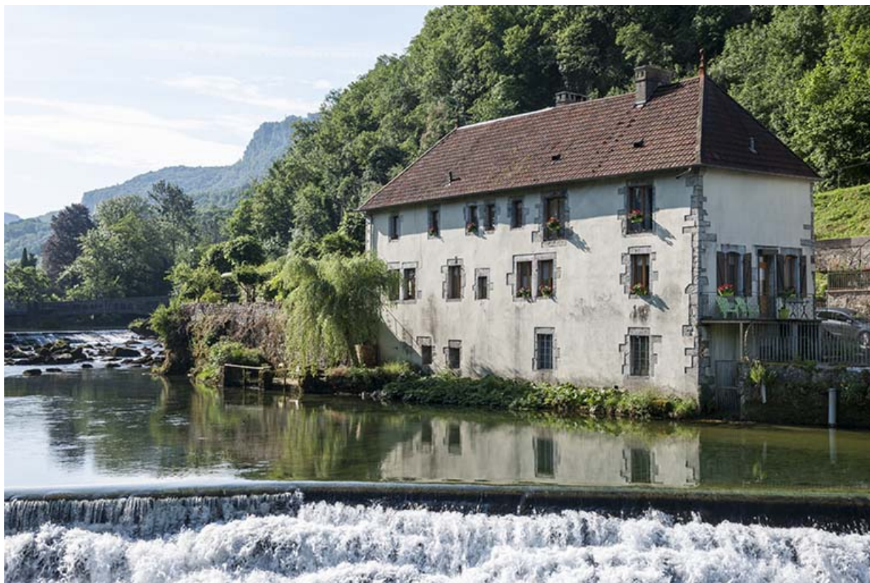
Logement d'ouvriers vu de trois quarts droite.
