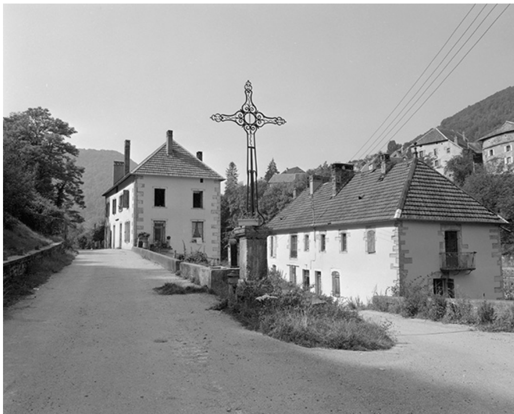
Logement d'ouvriers, vue depuis le chemin des forges.
