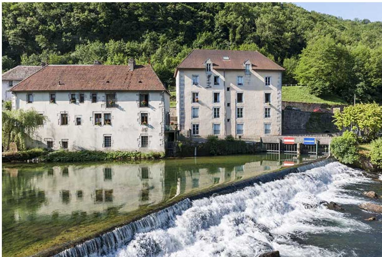
Façad nord des logements d'ouvriers.
