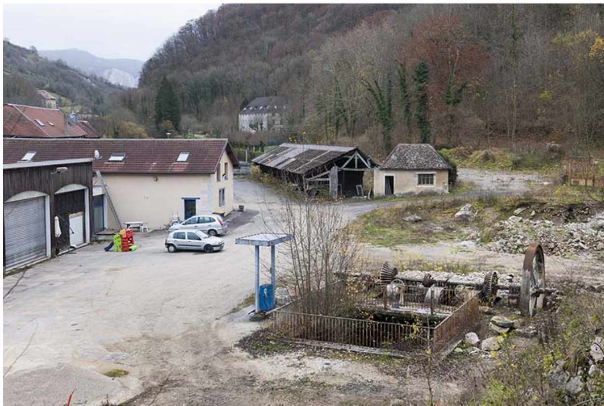
Vestiges de l'usine de tréfilerie du Moulin-Neuf. Vue depuis l'ouest. 25, Lods chemin des Forges
