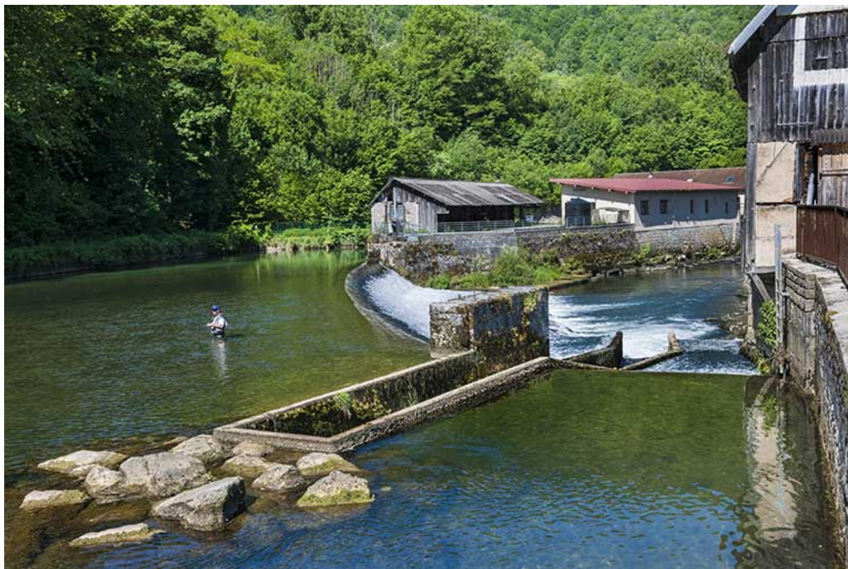
Le barrage de l'usine du Moulin-Neuf.
