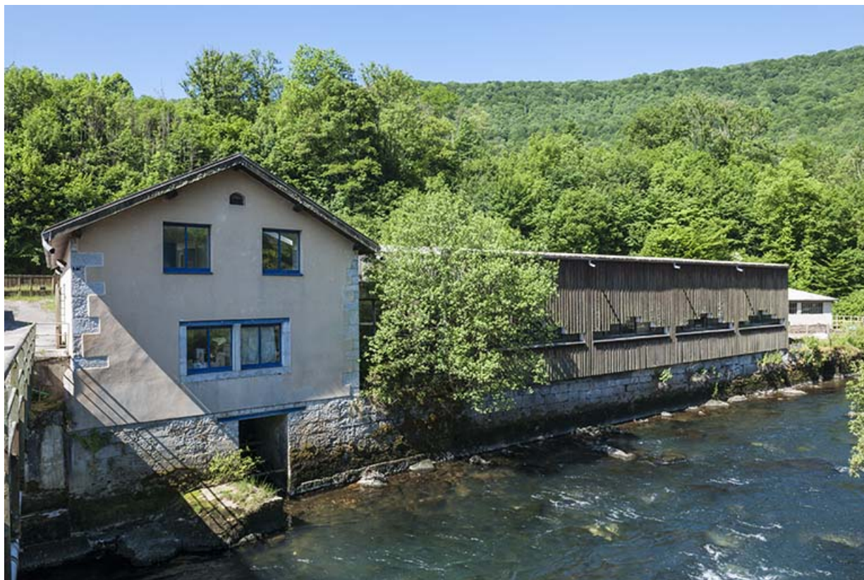
Usine du Moulin-Neuf. Bâtiments subsistants (logement ?).
