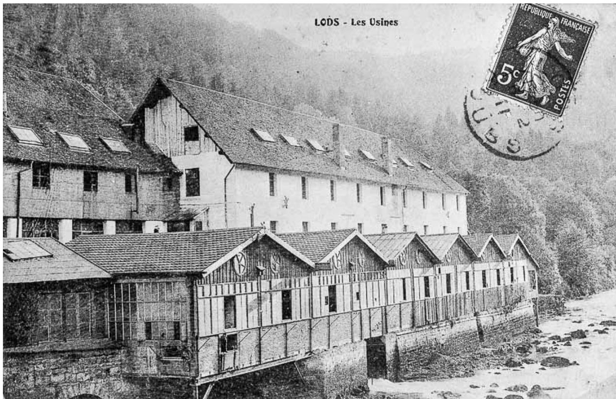
Lods - Les Usines, 1911. 25, Lods chemin des Forges
