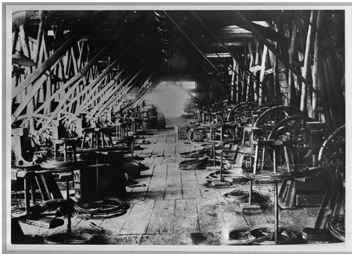
L'intérieur de la clouterie, limite 19e siècle 20e siècle.
