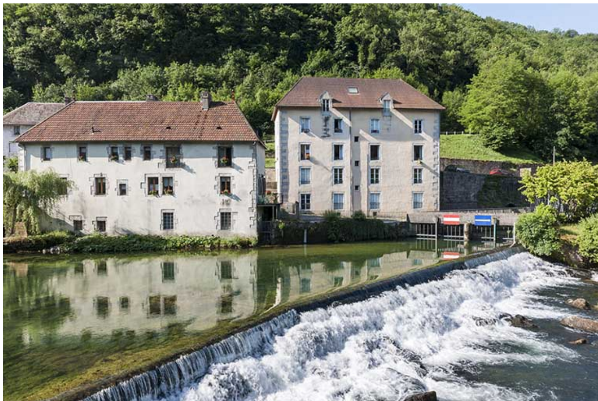
Façad nord des logements d'ouvriers.
