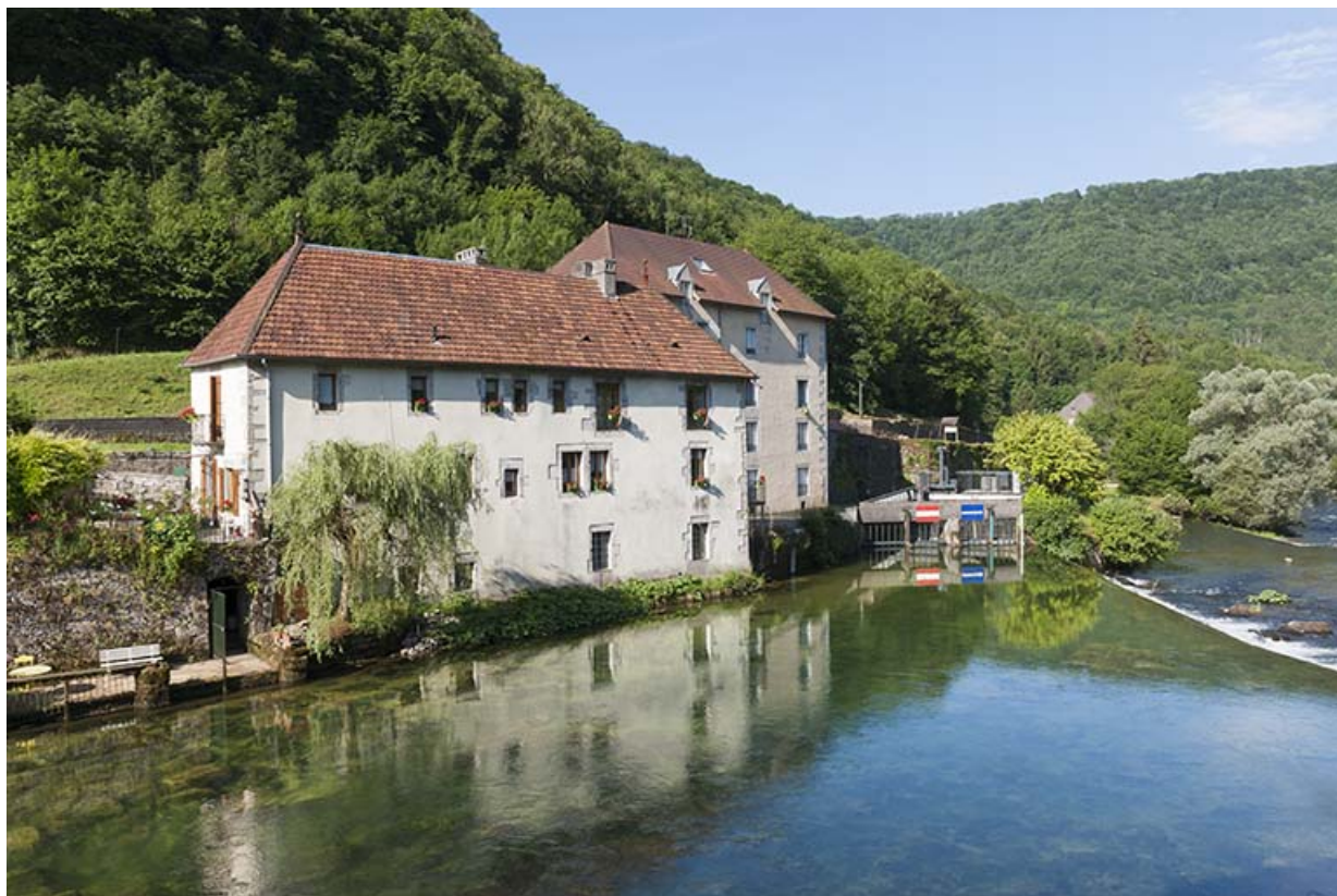
Logements d'ouvriers vus de trois quarts gauche.
