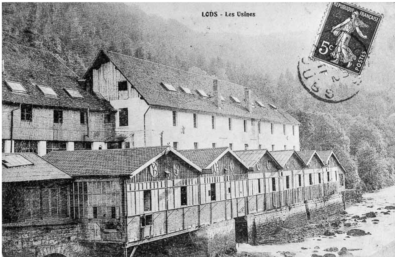
Lods - Les Usines, 1911. 25, Lods chemin des Forges
