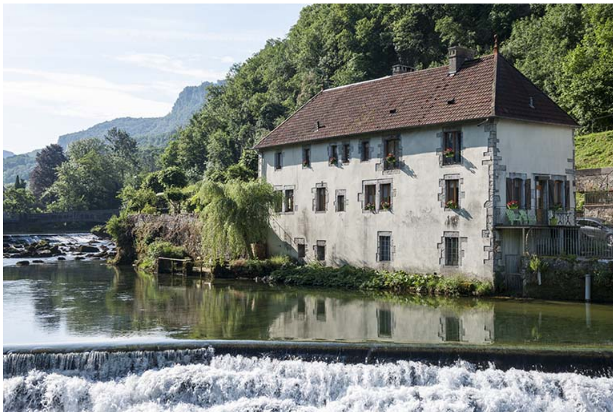
Logement d'ouvriers vu de trois quarts droite.
