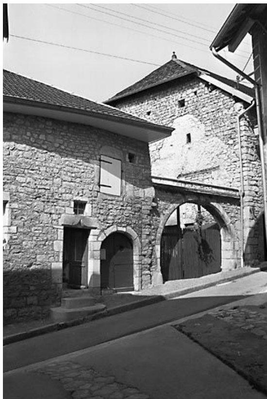
Vue d'ensemble depuis la rue de Jaubourg. 25, Lods
