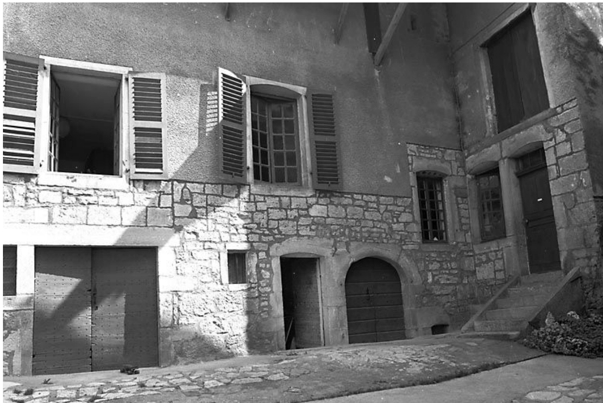
Élévation côté cour.
