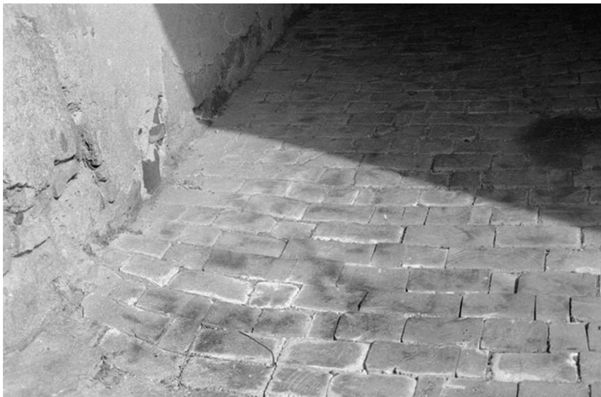
Maison située rue de l'Eglise (?), cadastrée 1971 AC 115, 116 : sol en bois du passage couvert. 25, Lods
