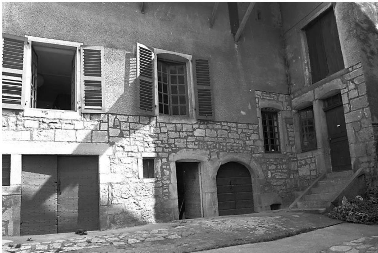
Élévation côté cour.
