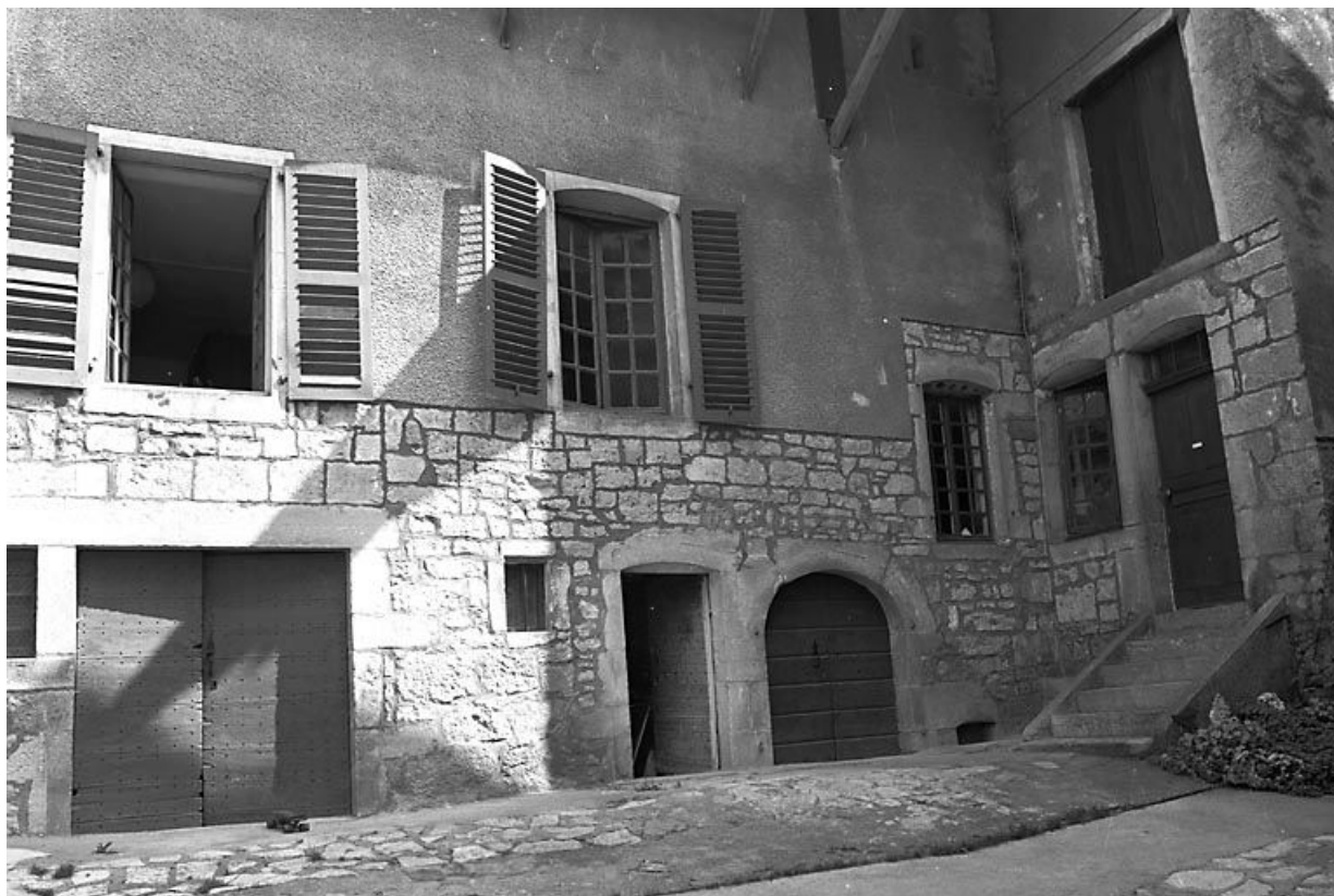
Élévation côté cour.
