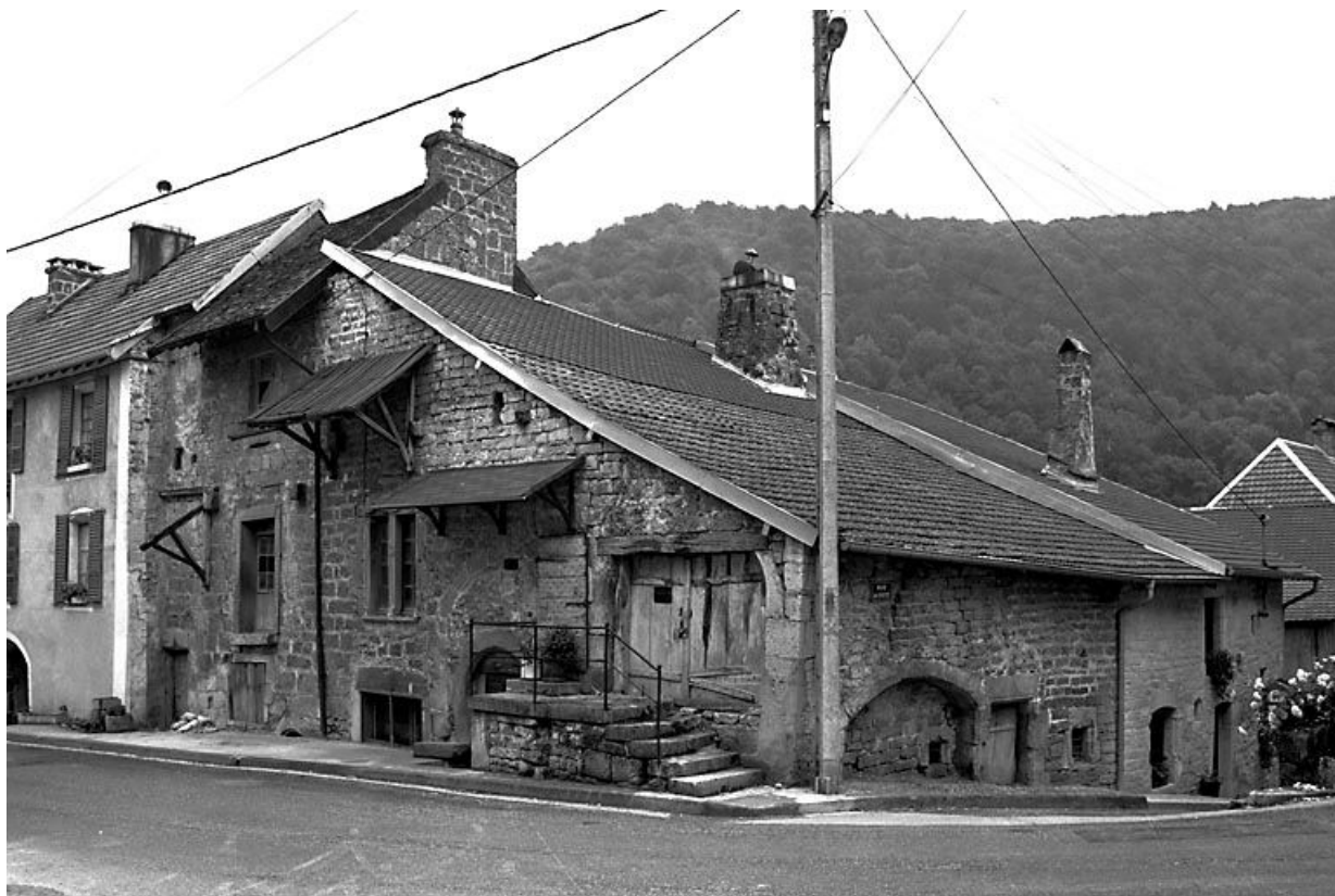
Façade antérieure et façade latérale droite. 25, Lods
