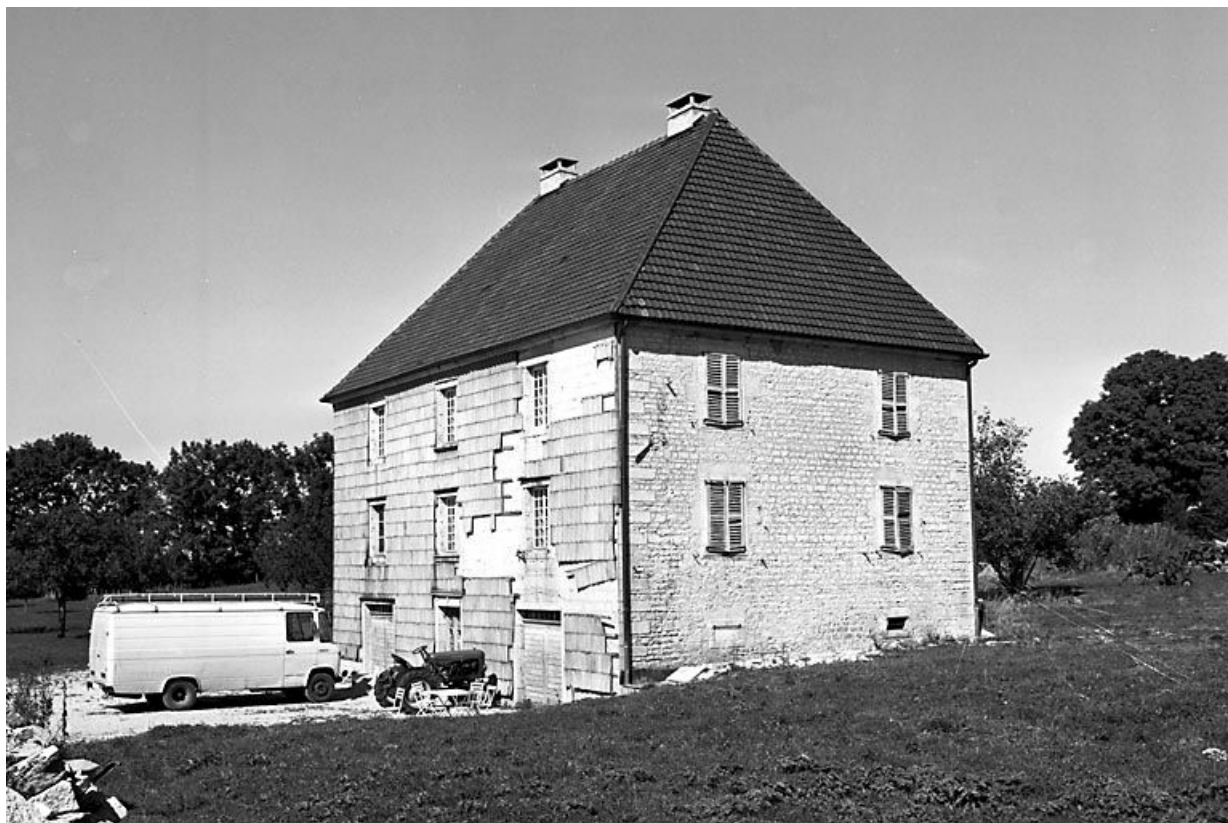
Façade antérieure et face latérale droite.
