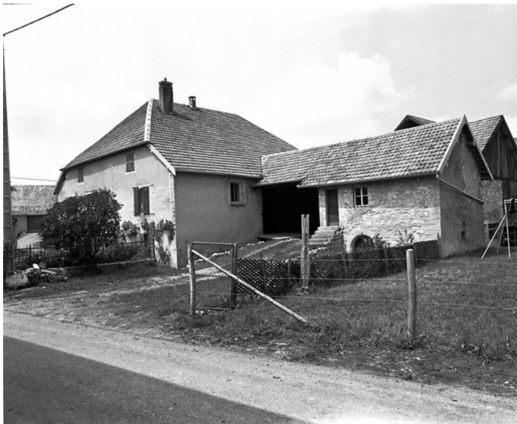
Façade antérieure et face latérale droite. 25, Lavans-Vuillafans, 29 Grande Rue
