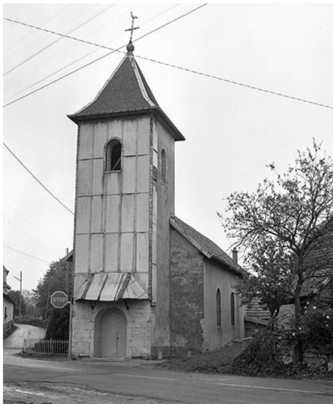
Façade antérieure et face latérale droite.
