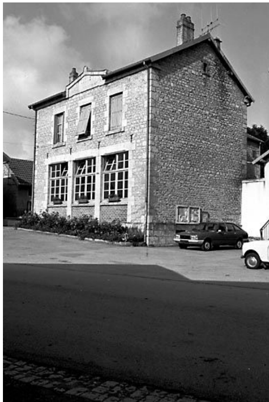
Façade postérieure et face latérale gauche. 25, L'Hôpital-du-Grosbois
