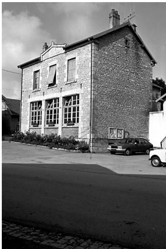
Façade postérieure et face latérale gauche. 25, L'Hôpital-du-Grosbois
