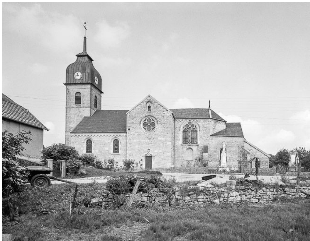
Façade latérale droite.
