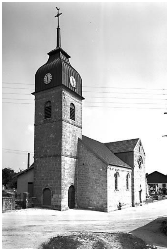
Façade antérieure et face latérale droite. 25, Guyans-Durnes
