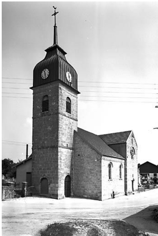
Façade antérieure et face latérale droite. 25, Guyans-Durnes
