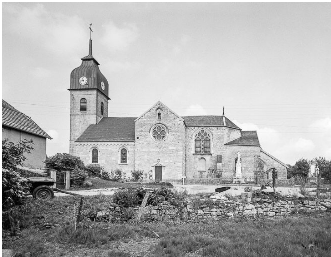
Façade latérale droite.
