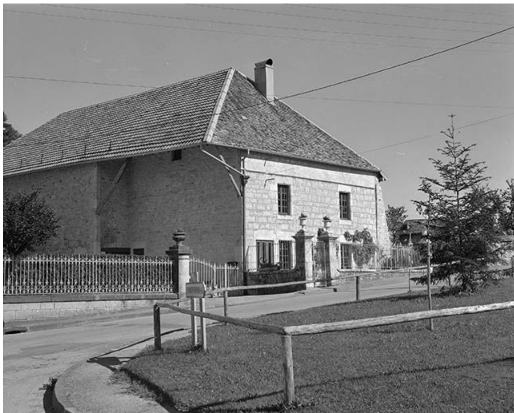
Façade antérieure et face latérale gauche de la ferme.
