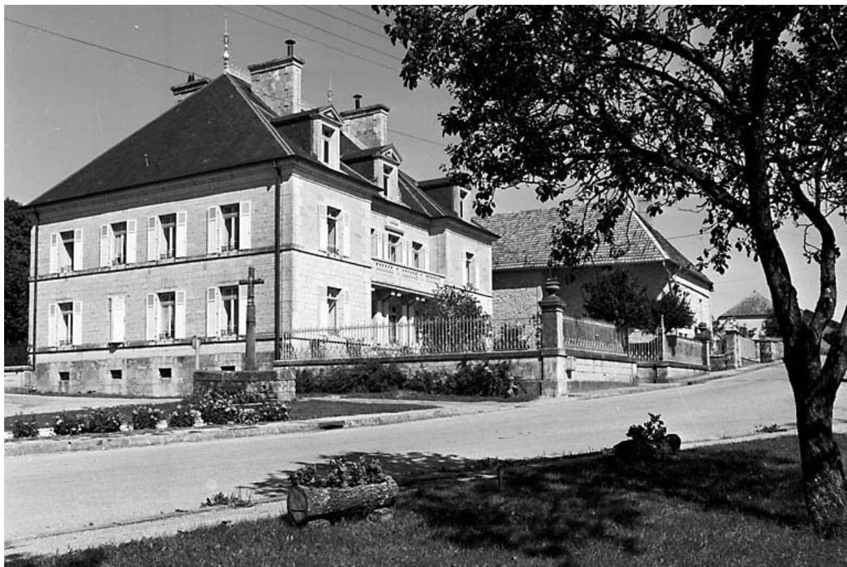
Vue d'ensemble de trois quarts gauche. 25, Guyans-Durnes, 27 rue Saint-Martin
