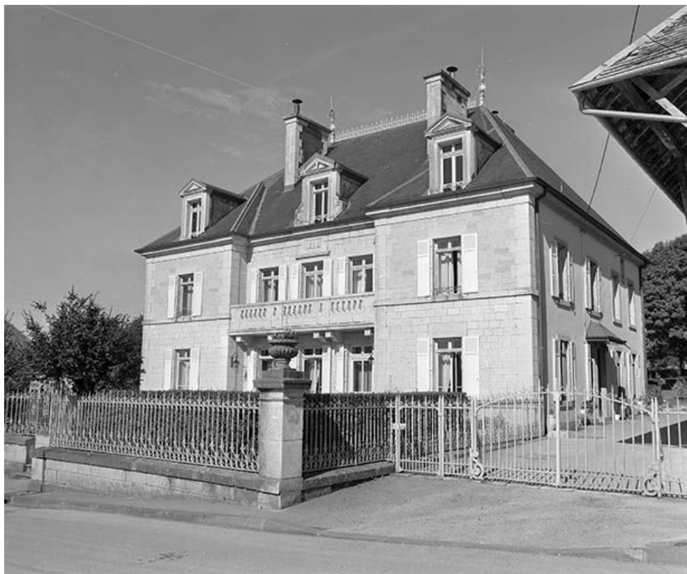
Façade antérieure et face latérale droite.
