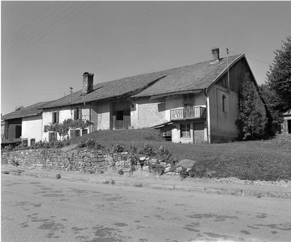
Façade antérieure et face latérale droite.
