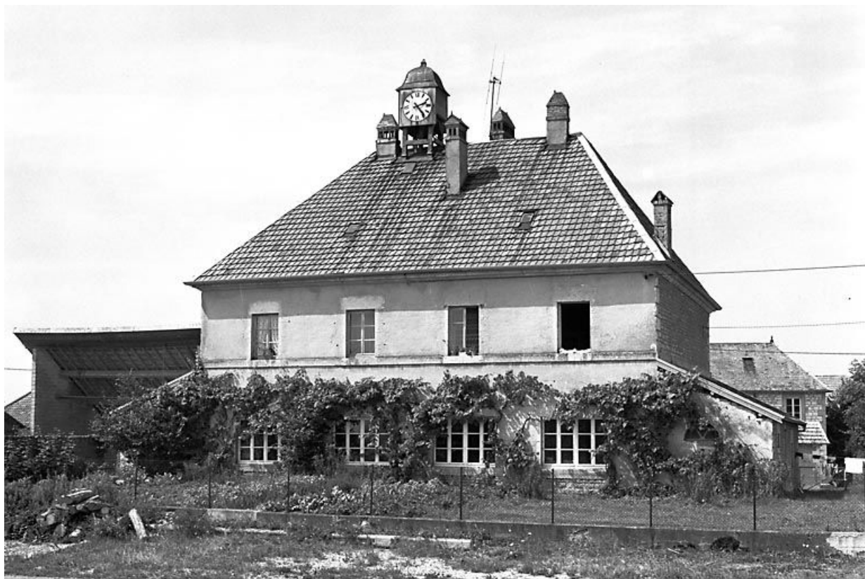
Façade antérieure. 25, Foucherans
