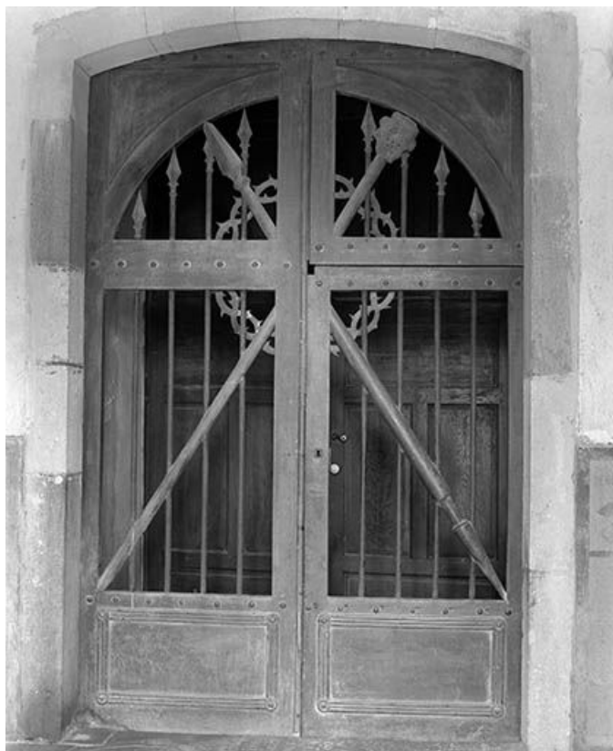
Porte conduisant à la nef.
