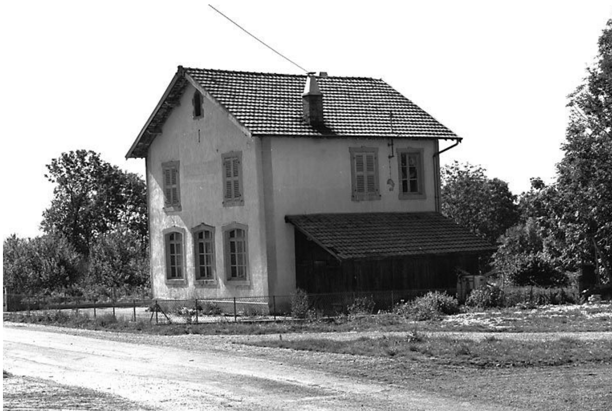
Façade postérieure et face latérale droite. 25, Échevannes
