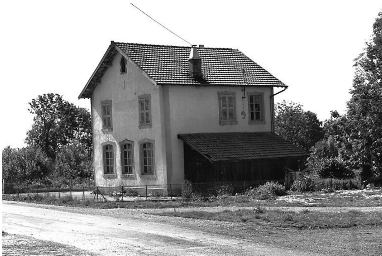
Façade postérieure et face latérale droite. 25, Échevannes
