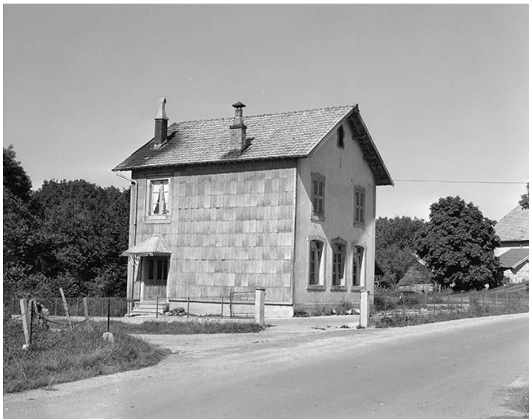
Façade antérieure et face latérale droite.
