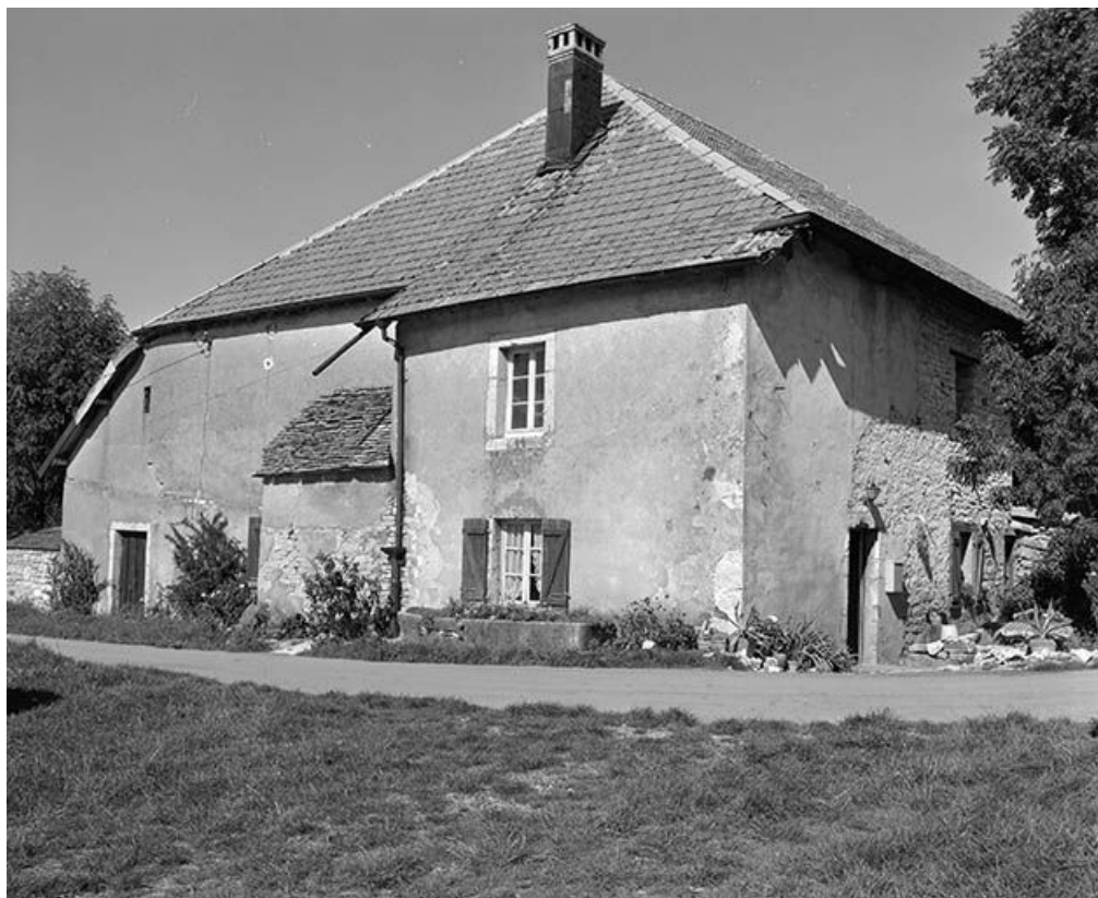
Façade antérieure et face latérale gauche. 25, Échevannes chemin des Jardins
