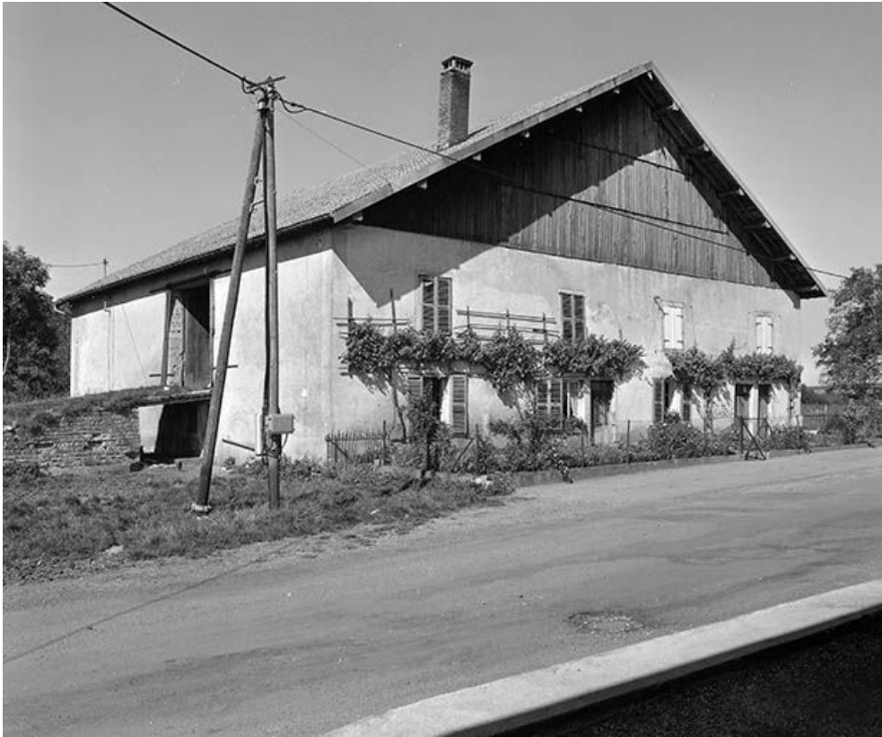
Façade antérieure et face latérale gauche. 25, Échevannes
