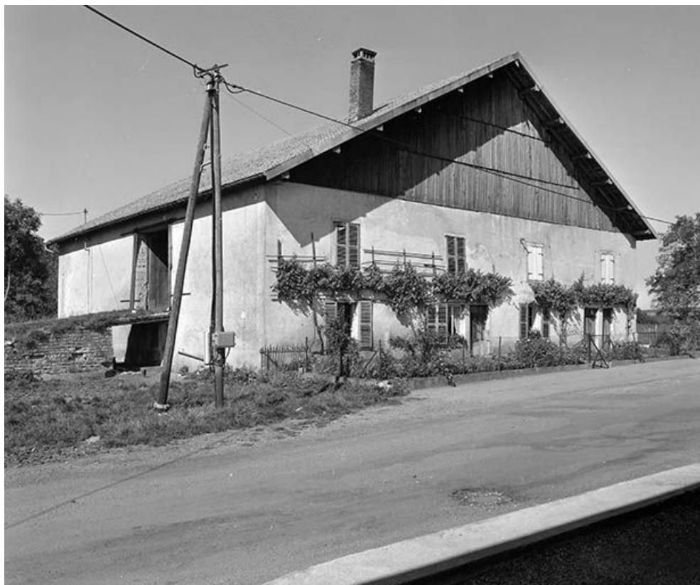
Façade antérieure et face latérale gauche. 25, Échevannes
