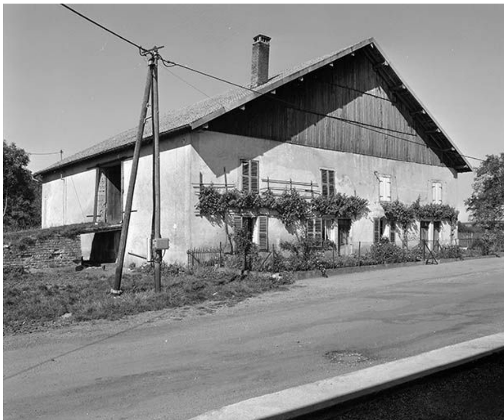
Façade antérieure et face latérale gauche. 25, Échevannes
