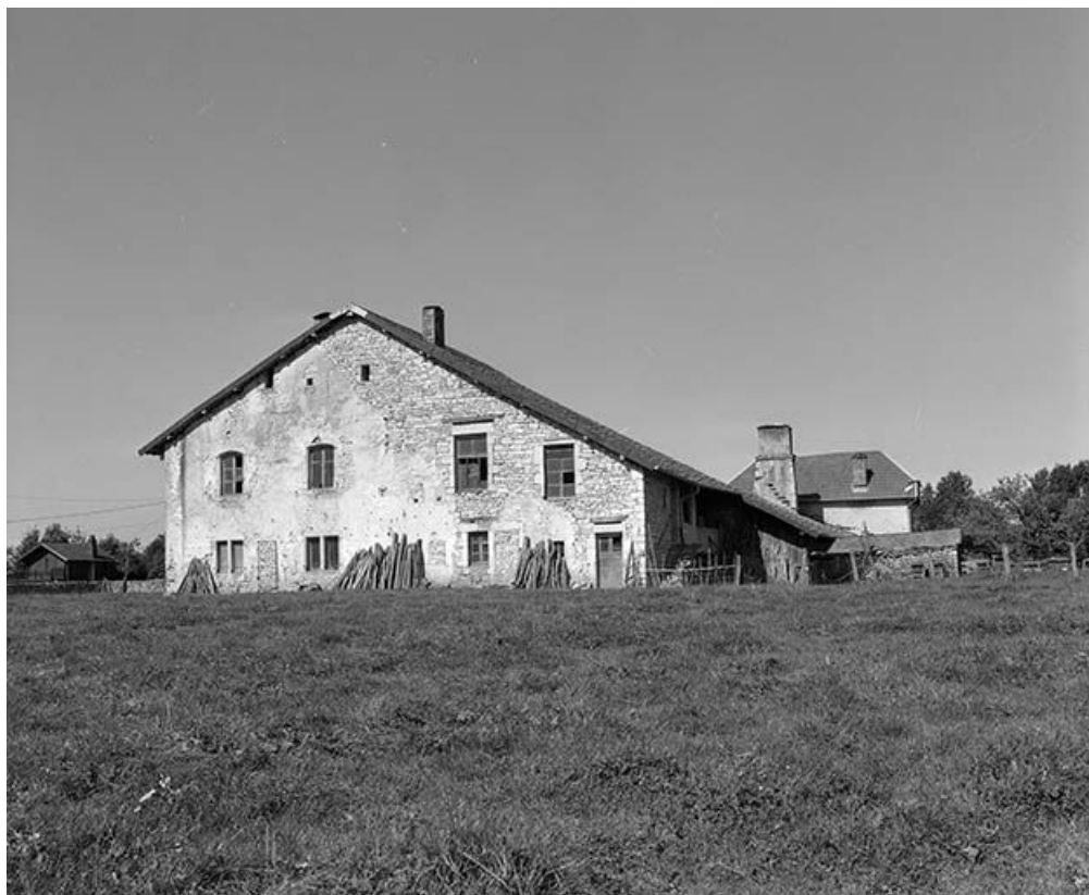
Façade antérieure et face latérale droite.
