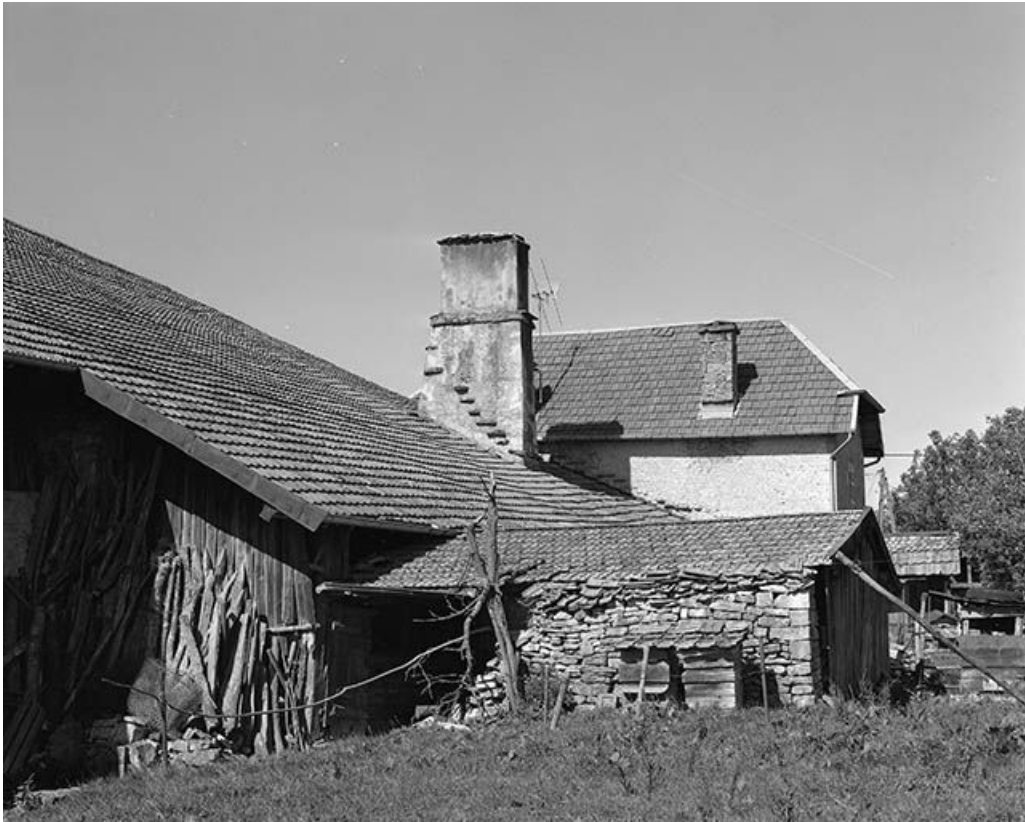
Vue extérieure de la cheminée centrale en pierre (tué). 25, Durnes rue du Château
