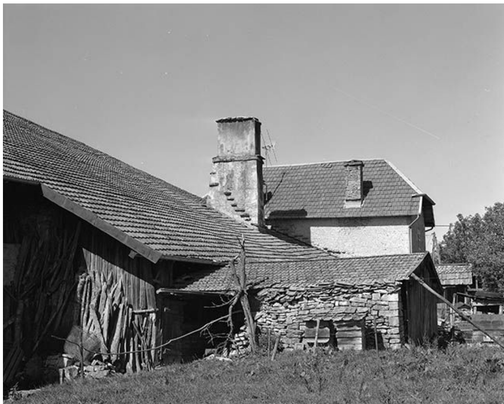
Vue extérieure de la cheminée centrale en pierre (tué).
