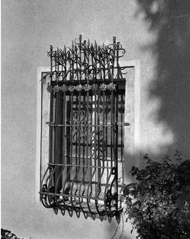
Une des baies du rez-de-chaussée des communs.
