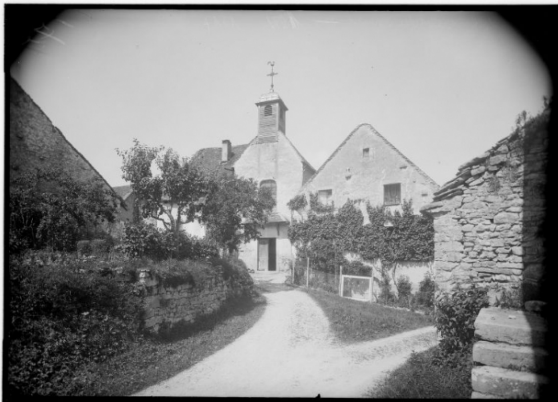
Vue d'ensemble, [1e moitié 20e siècle]. 25, Châteauvieux-les-Fossés rue Ferdinand de Rye
