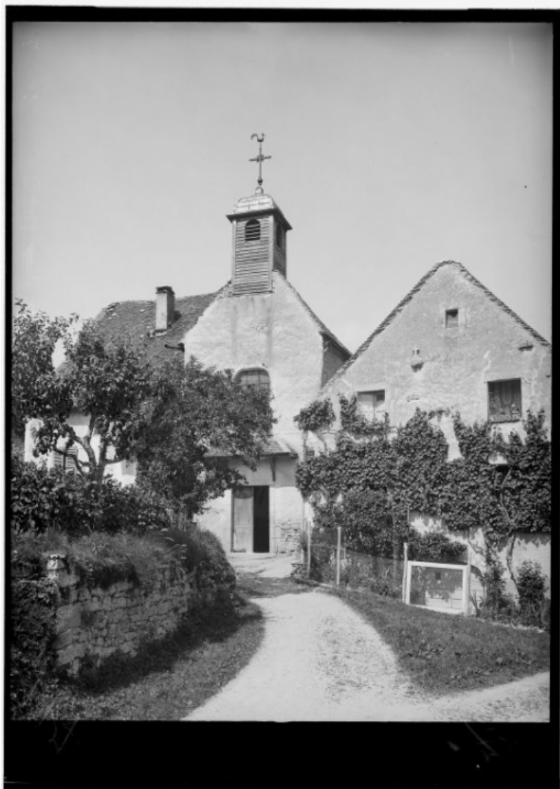
Vue d'ensemble [1e moitié 20e siècle]. 25, Châteauvieux-les-Fossés rue Ferdinand de Rye
