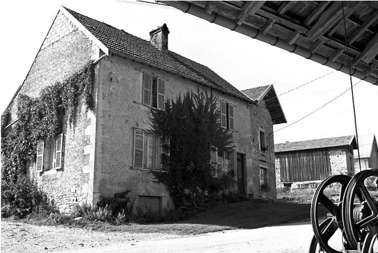
Façade antérieure et face latérale gauche. 25, Chassagne-Saint-Denis
