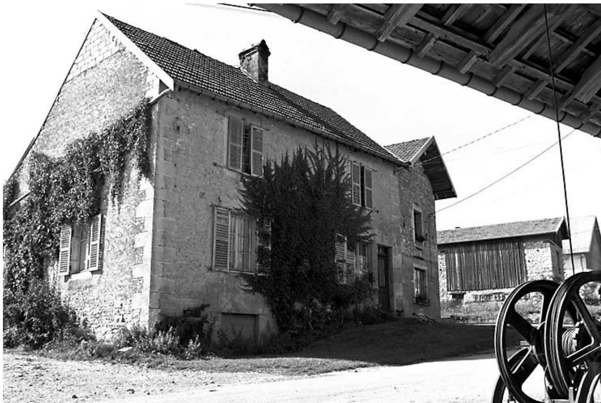
Façade antérieure et face latérale gauche. 25, Chassagne-Saint-Denis
