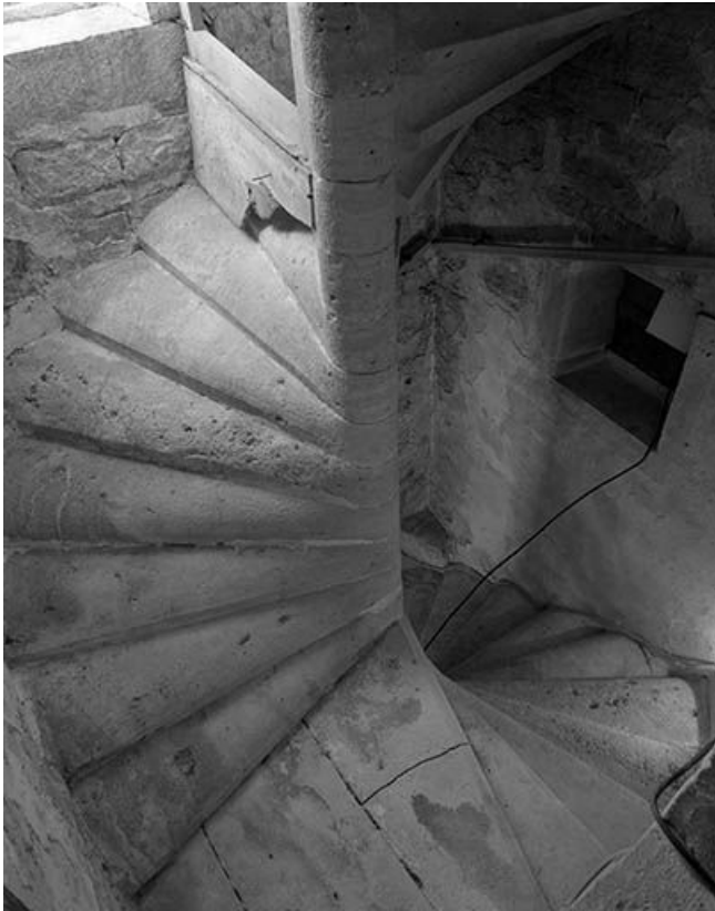
Intérieur : l'escalier en vis.
