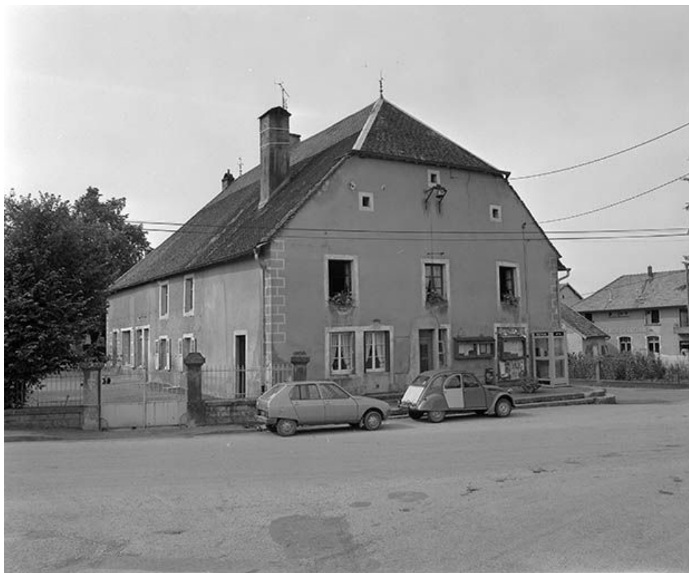
Façade antérieure et face latérale gauche. 25, Chantrains
