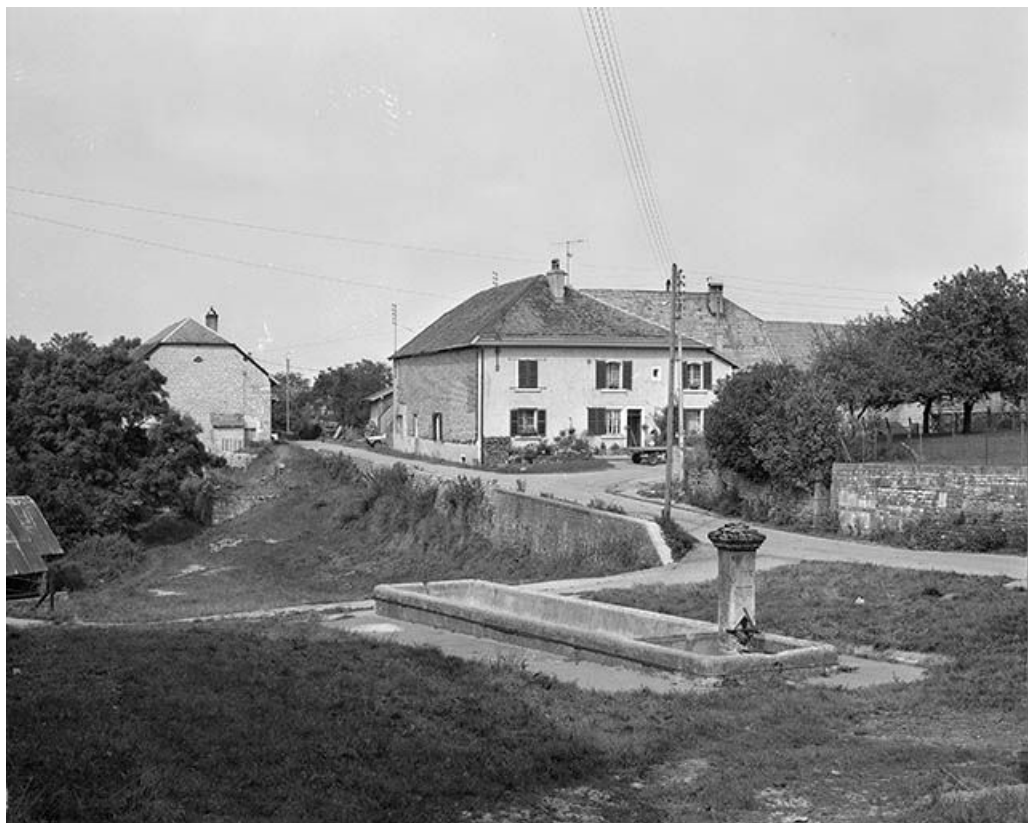
La fontaine supérieure. 25, Chantrains
