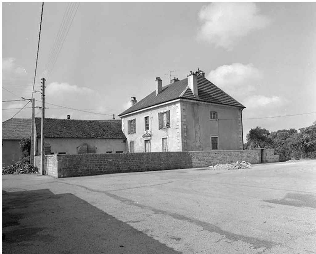
Façade antérieure et face latérale droite. 25, Chantrains rue de l' Eglise
