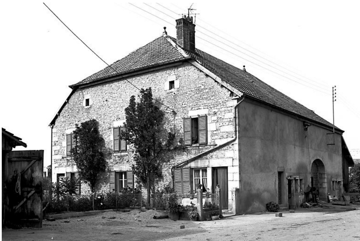
Façade antérieure et face latérale droite. 25, Chantrans
