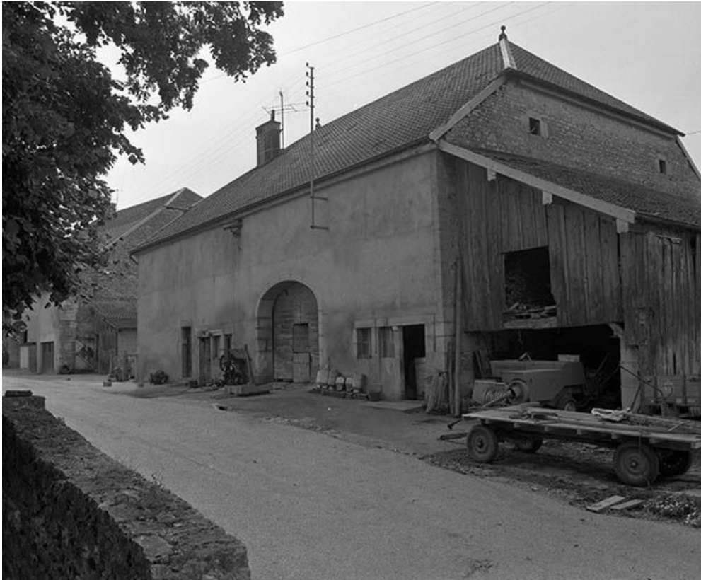
Face latérale droite vue de trois quarts droit. 25, Chantrains rue de l' Ecole
