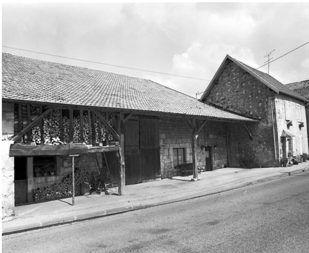
Façade antérieure de trois quarts gauche. 25, Chantrans route de Salins
